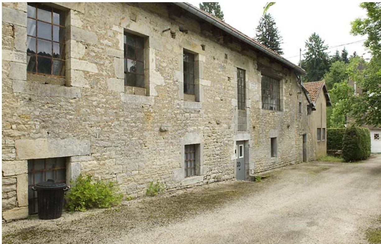
Façade ouest de l'atelier de fabrication.
