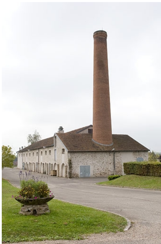
Vue depuis l'est (cadrage vertical).
