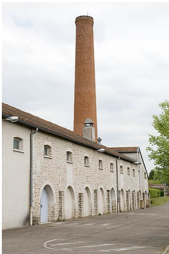
Façade nord vue de trois quarts gauche.
