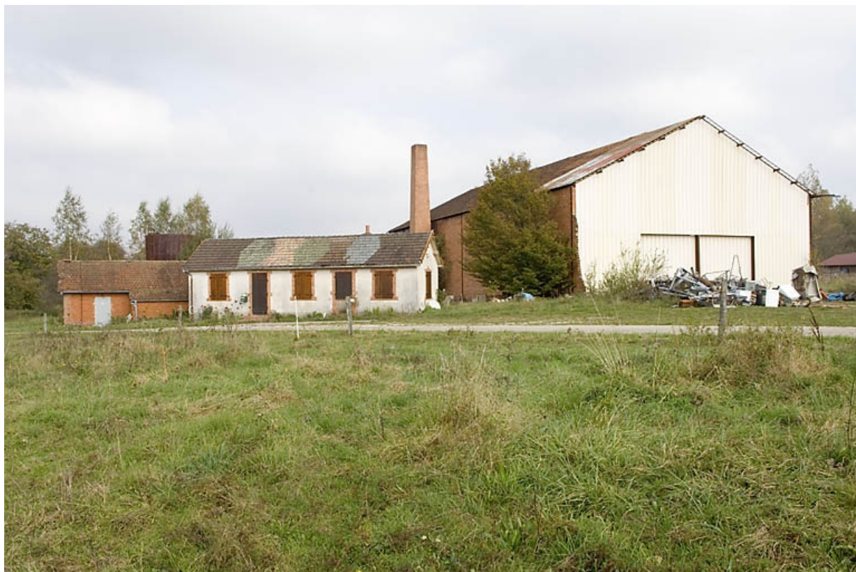
Bureau (?) et atelier de fabrication depuis le sud-ouest.
