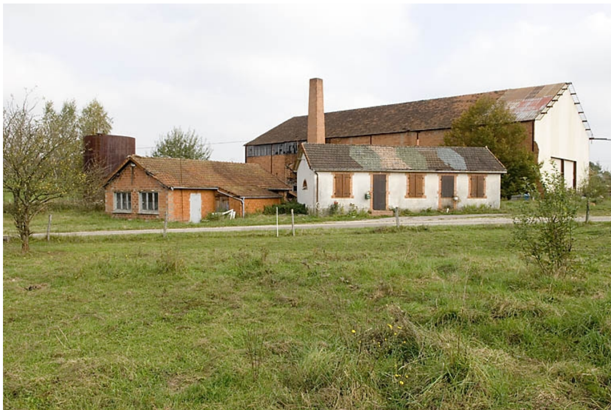
Vue d'ensemble depuis l'ouest.
