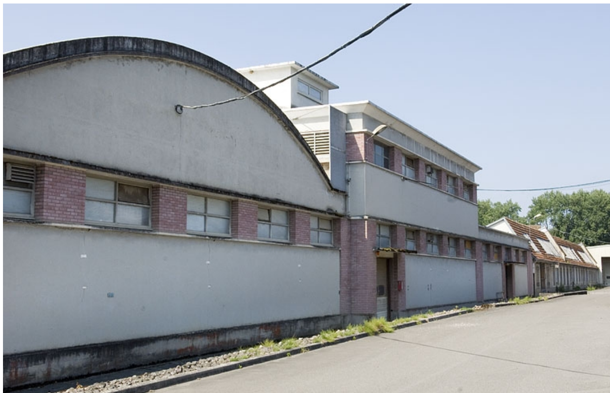
Façade nord de l'atelier de filature.
