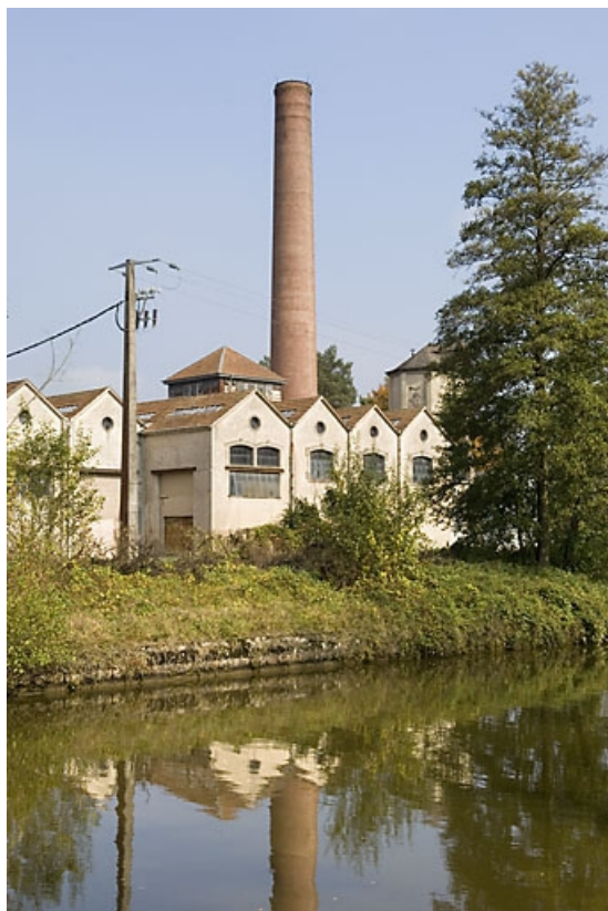
L'usine et le canal.
