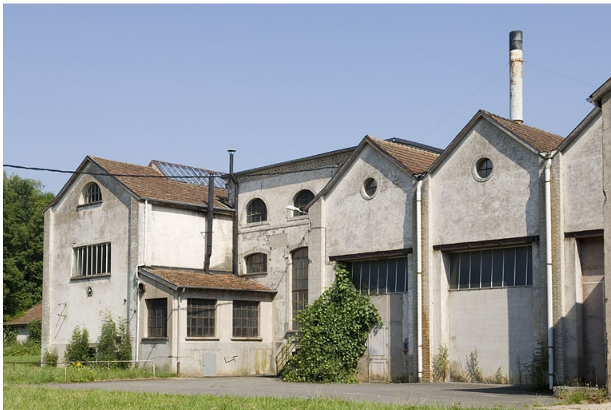
Façades sud de la salle des machines et de la chaufferie.
