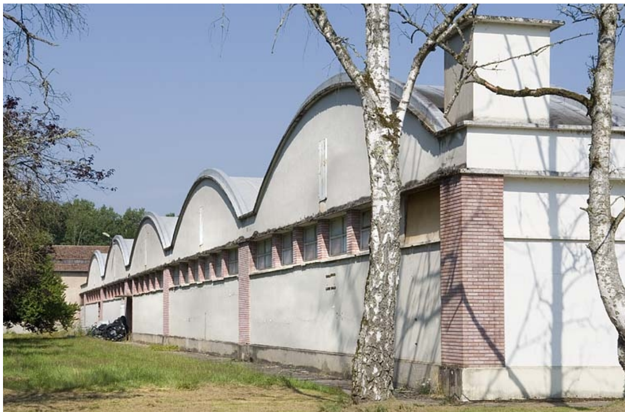
Atelier de filature. Pignons segmentaires de la façade sud.
