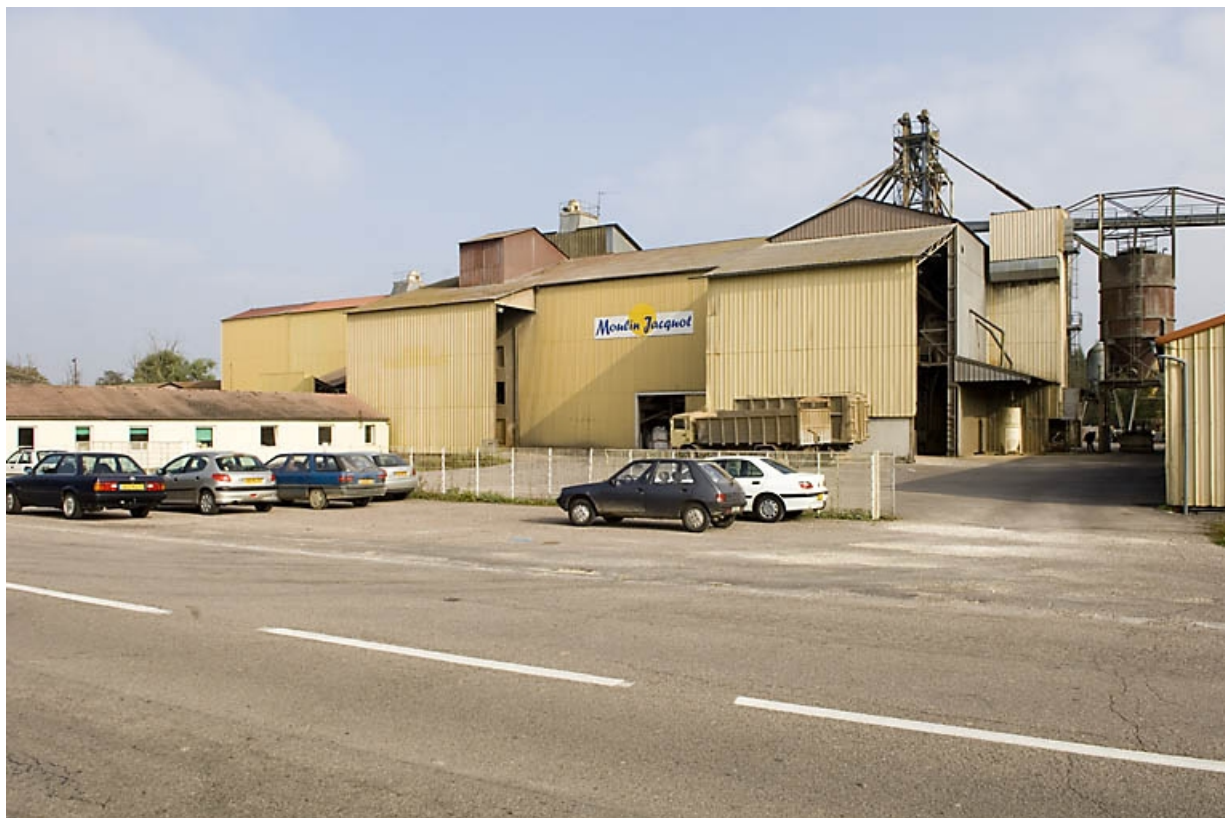
Façades sud de la minoterie depuis le faubourg Louis Boulanger. 70, Corre, 1 faubourg Louis Boulanger
