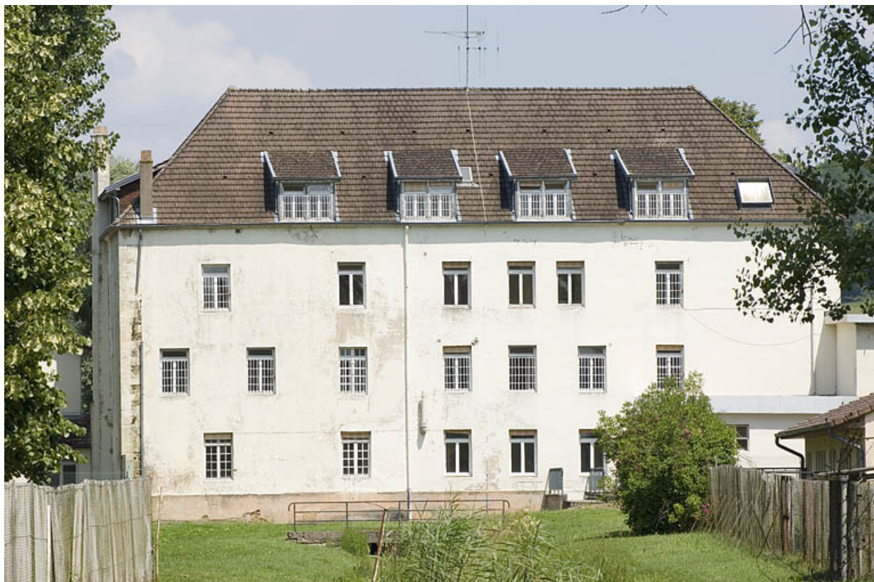
Façade postérieure depuis l'aval du bief.
