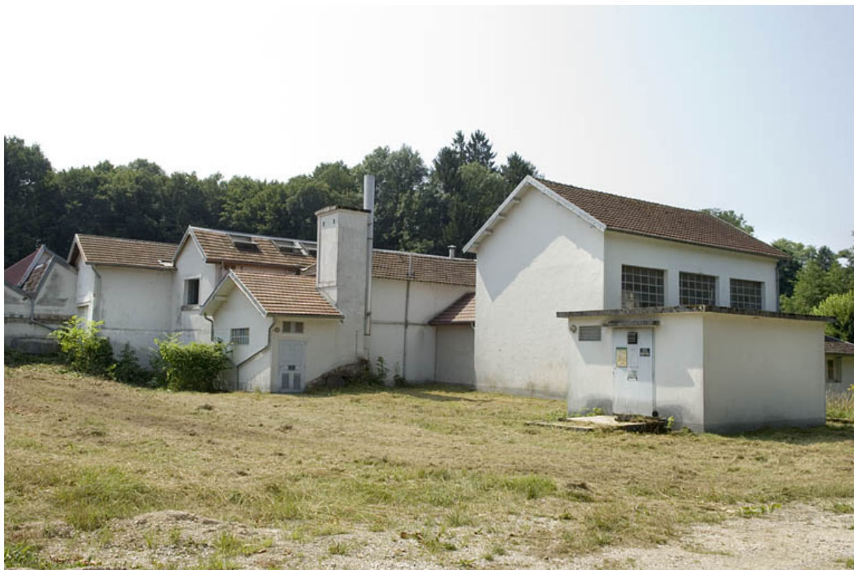
Salle des machines et bâtiment d'eau vus de trois quarts arrière. 70, La Côte rue du Tissage
