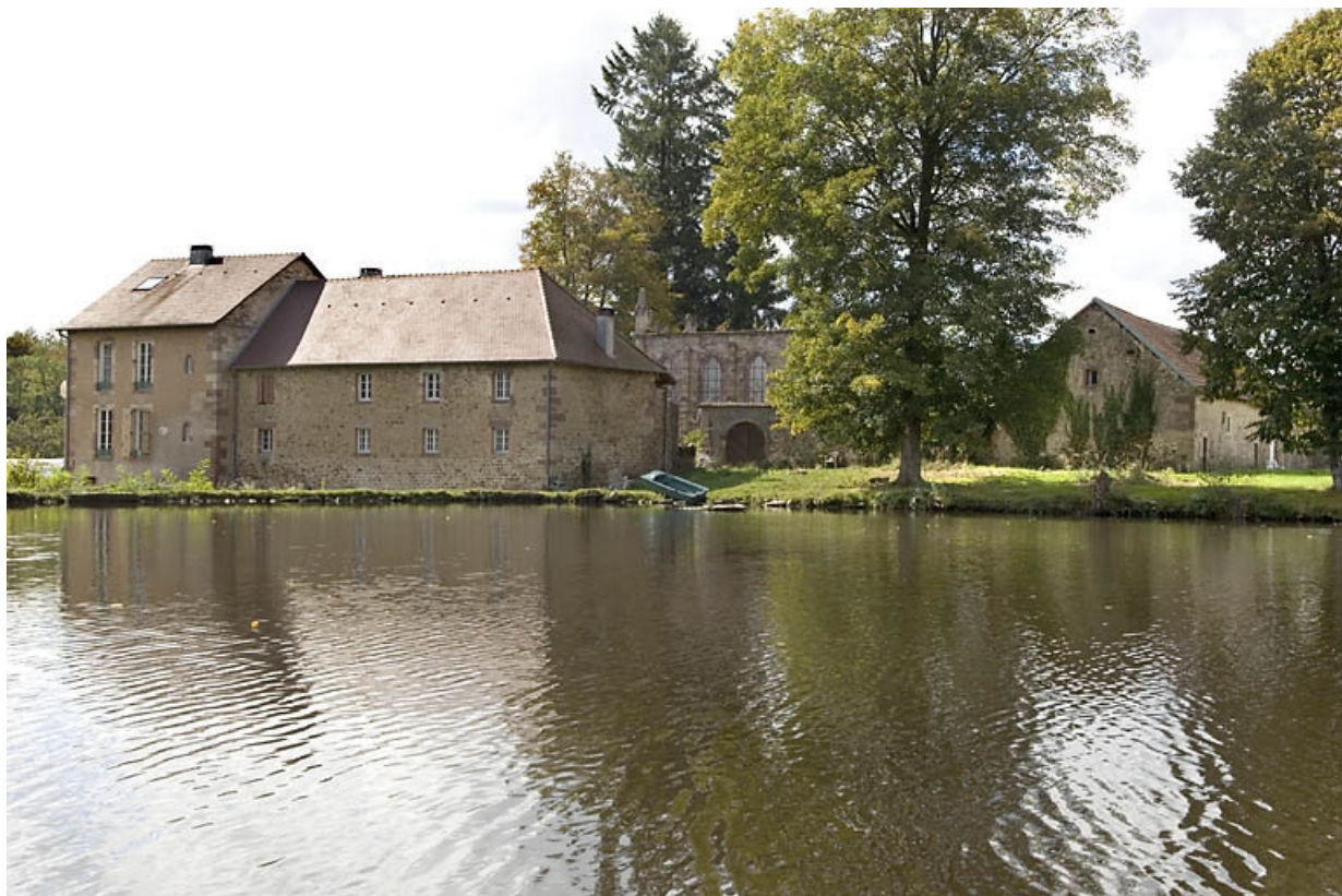
Logements est et chapelle. Vue depuis le nord-est.
