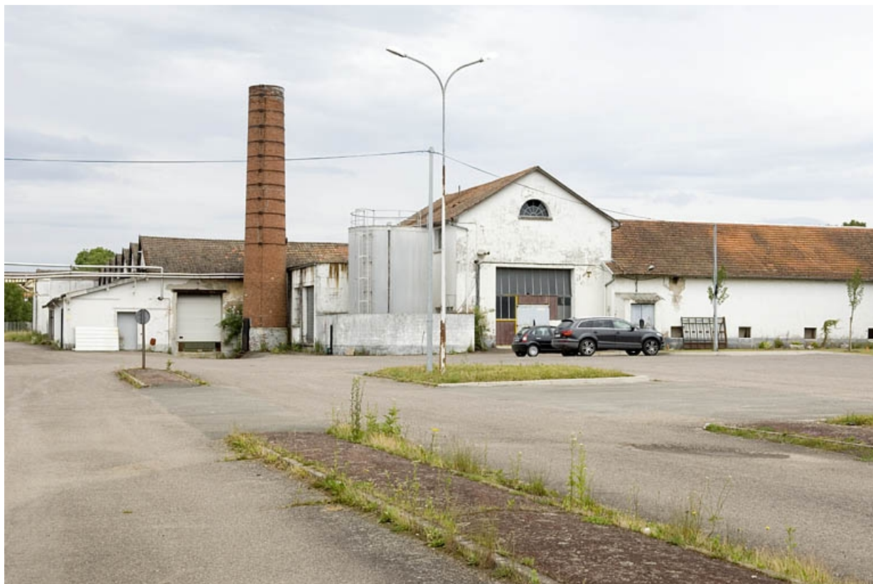
Atelier de fabrication, cheminée et salle des machine depuis le sud-ouest. 70, Saint-Germain, lieudit : le Saulcy
