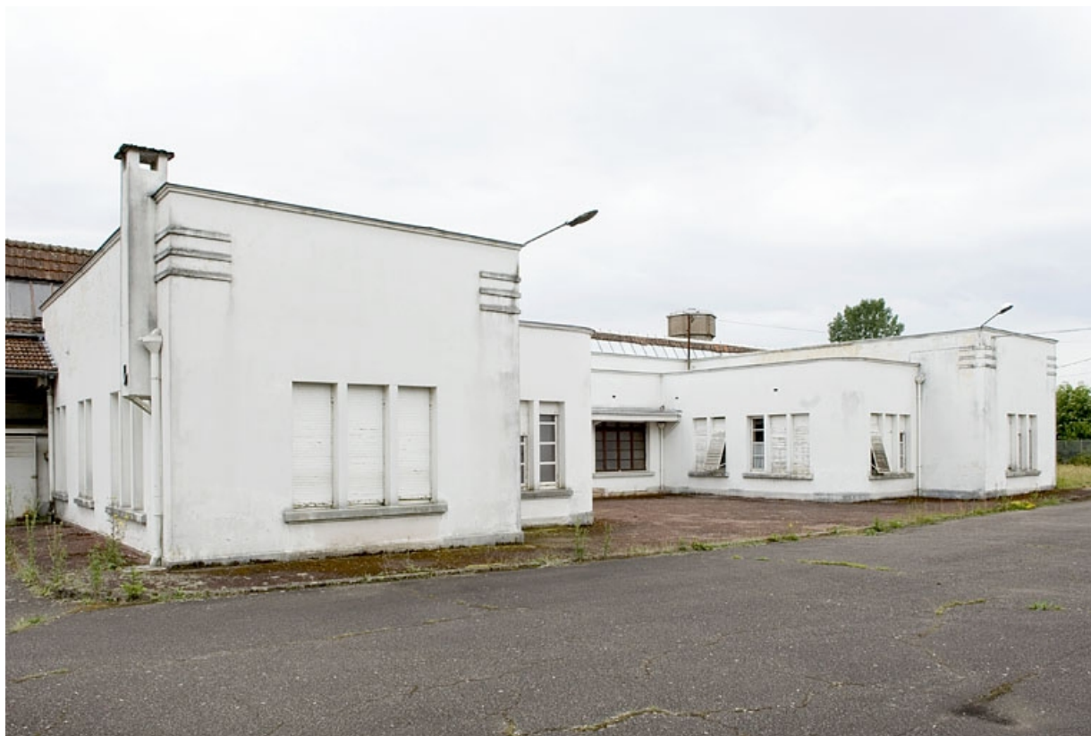
Les bureaux. Vue de trois quarts gauche.
