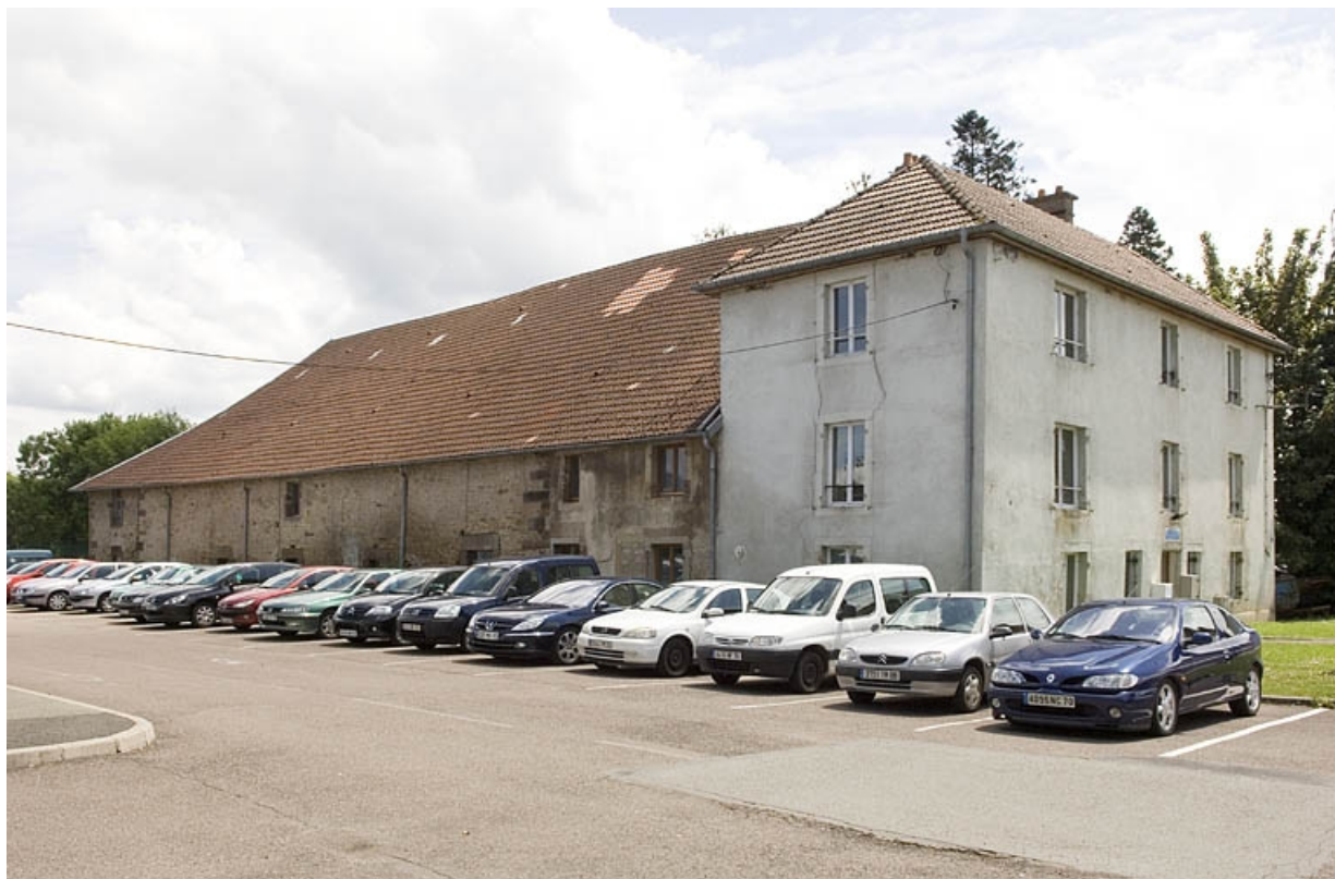
Bâtiment des commis, des écuries et des remises. Vue d'ensemble.
