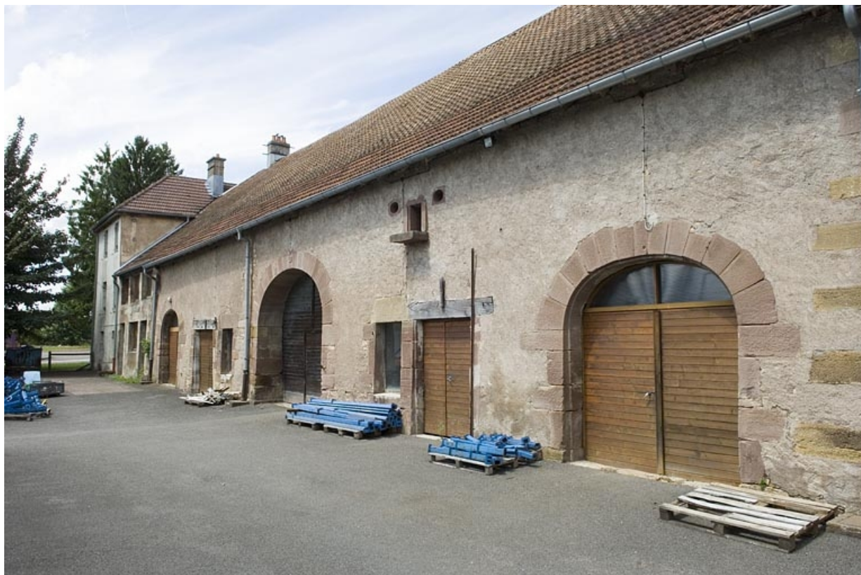
Bâtiment des écuries et des remises. Façade sud.
