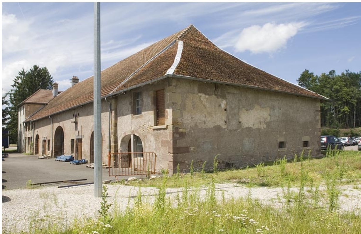
Bâtiment des écuries et des remises. Vue de trois quarts.
