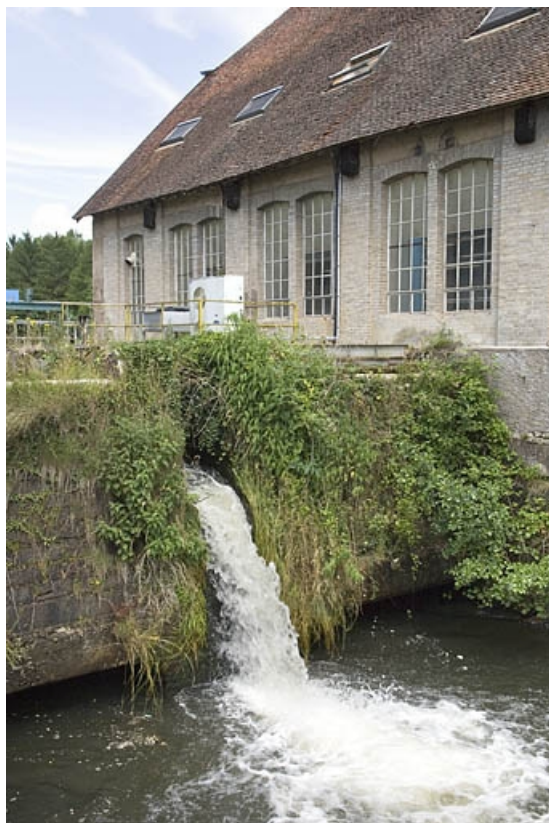
Chute à l'emplacement de l'ancien bâtiment d'eau, et extrémité nord de la forge neuve.
