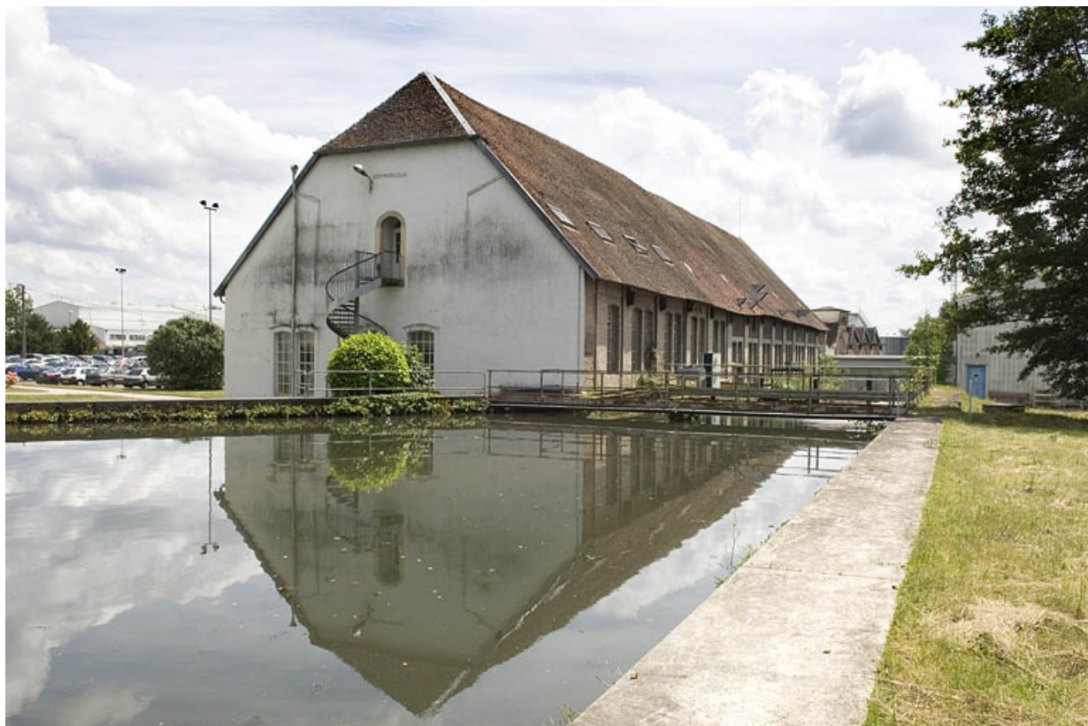
Atelier de fabrication dit forge neuve. Vue depuis le bief d'amenée.
