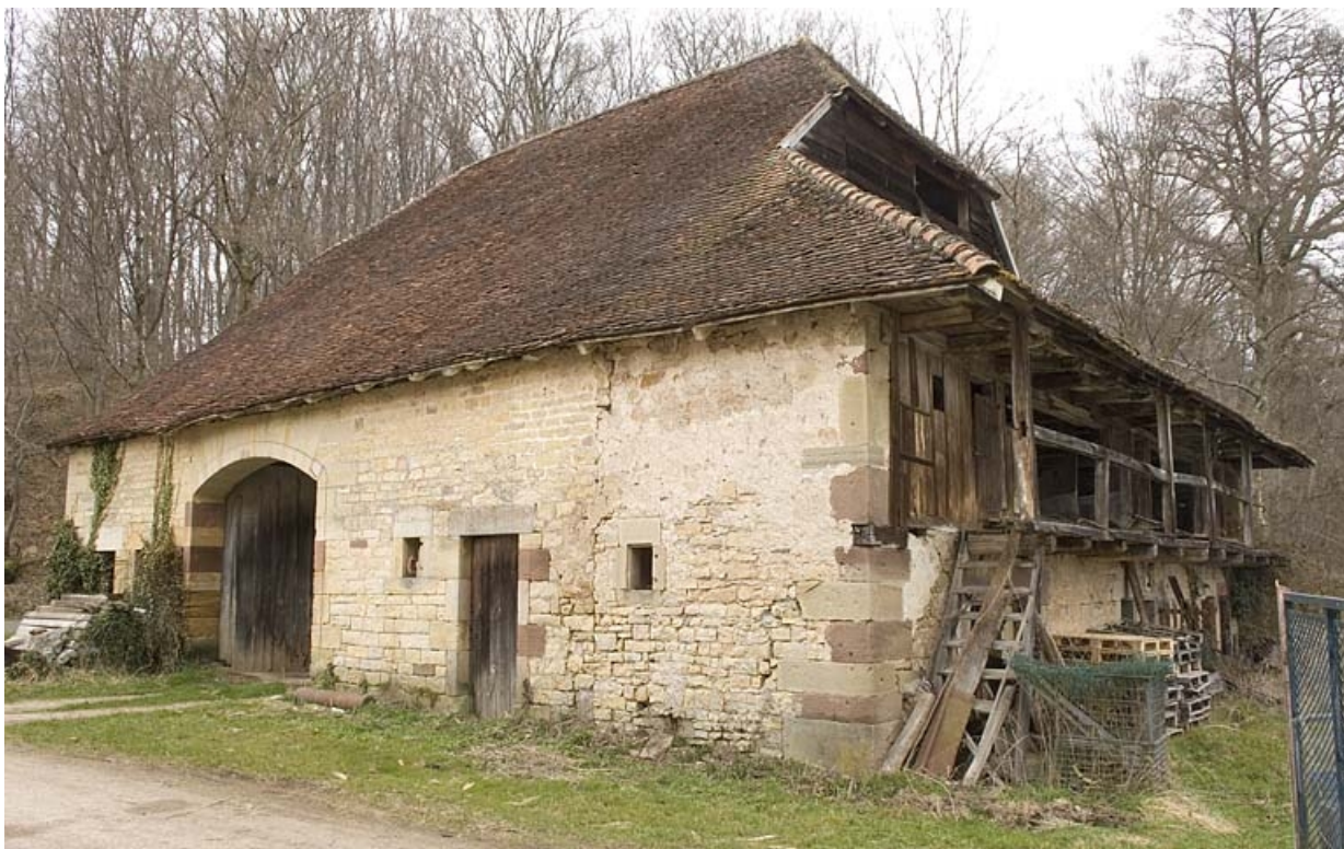
Bâtiment agricole (remise, grange, écurie). Vue de trois quarts.
