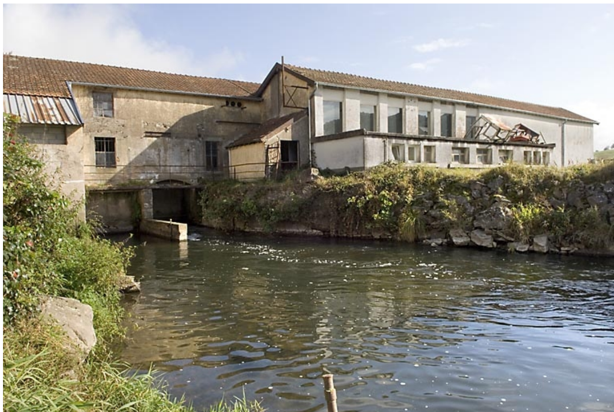
Canal de fuite et atelier de fabrication depuis le sud.
