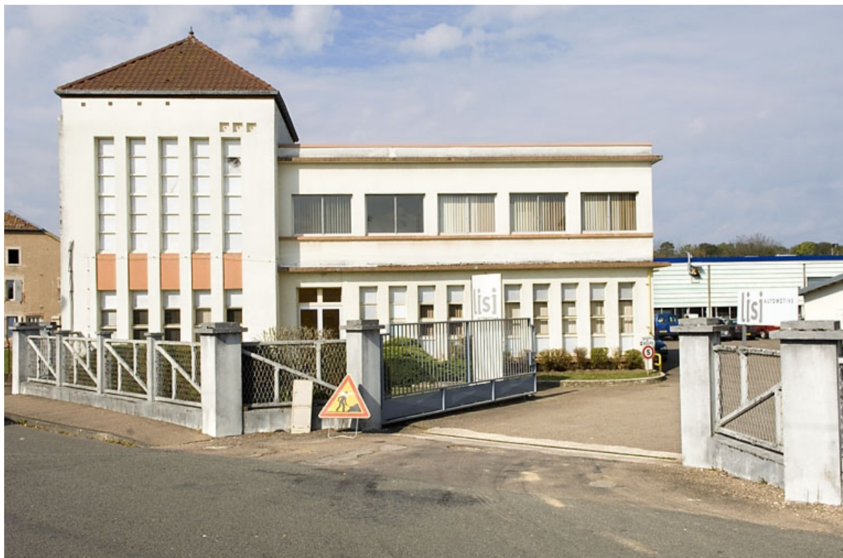
Façade antérieure. Transformateur et bureau.
