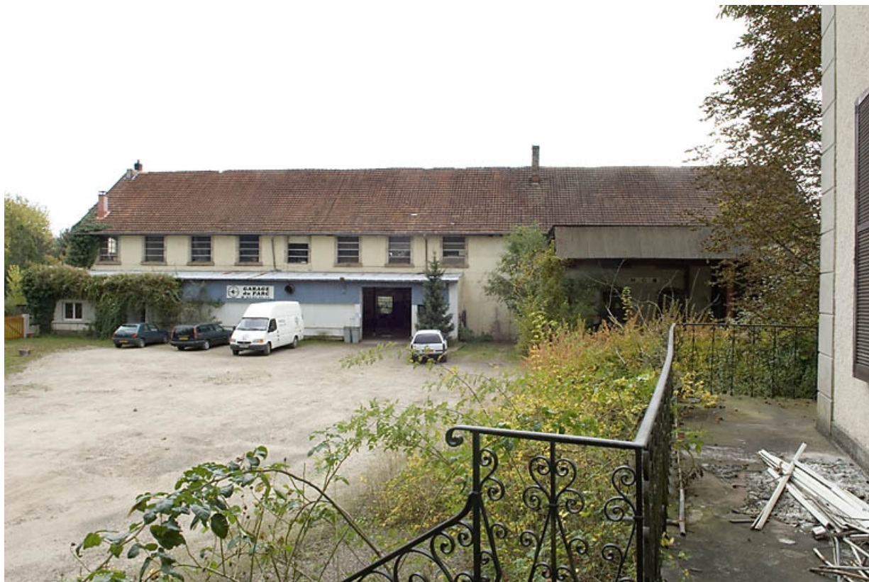
Atelier de fabrication. Vue depuis le nord-ouest.
