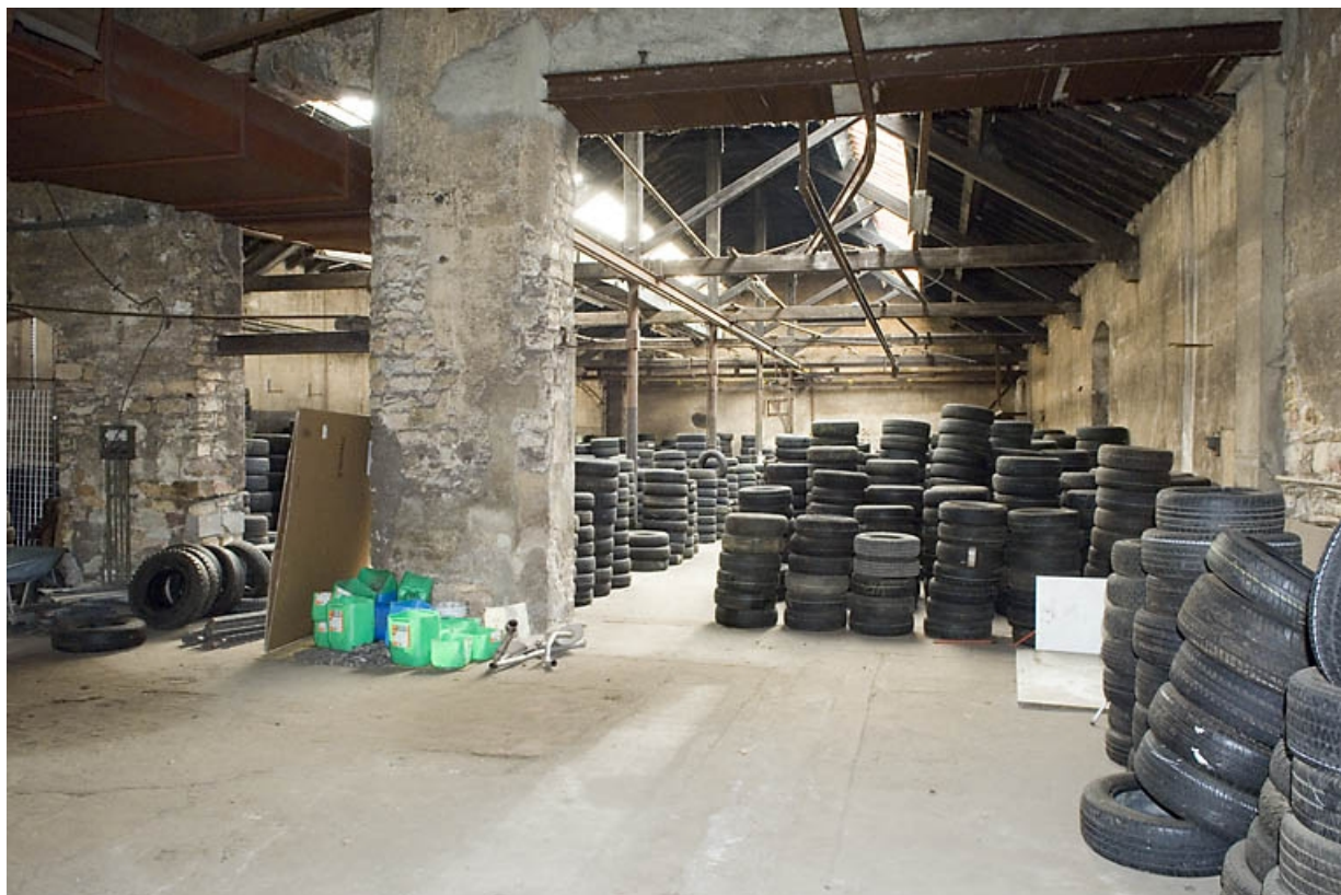
Vue intérieure de l'atelier de fabrication.
