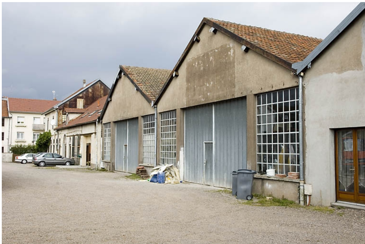
Façades et murs-pignons des ateliers de fabrication. Vue depuis le sud. 70, Lure, 14, 16 rue des Gleux
