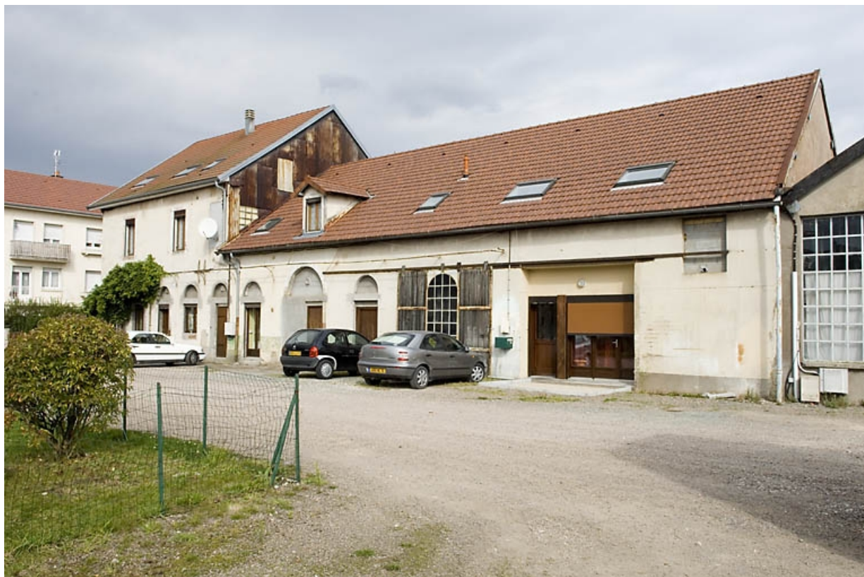
Façades sur cour: logement patronal et ancien atelier de fabrication (?). 70, Lure, 14, 16 rue des Gleux
