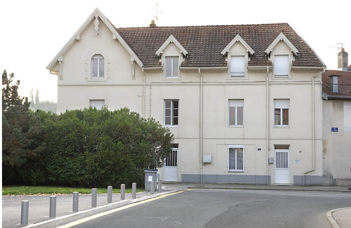
Logement ouvrier (?). Vue de face.
