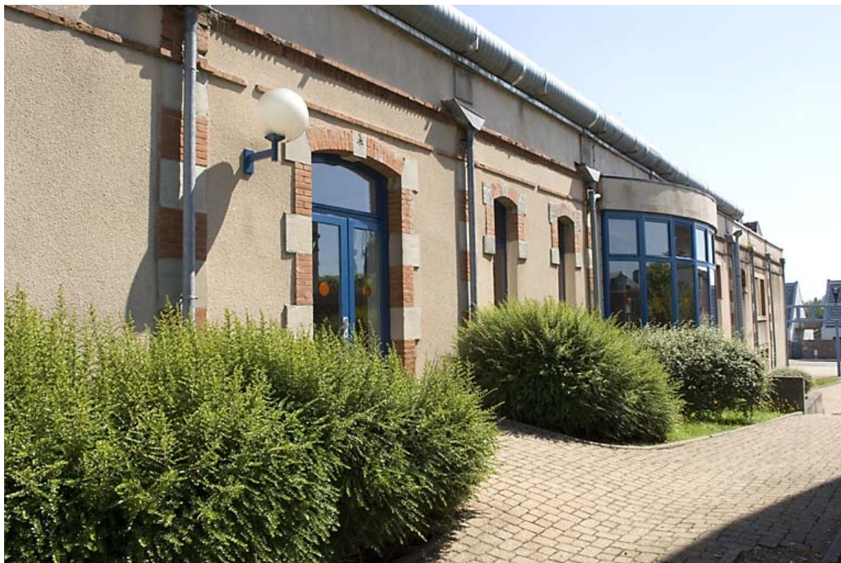
Façade sud de l'atelier de fabrication.
