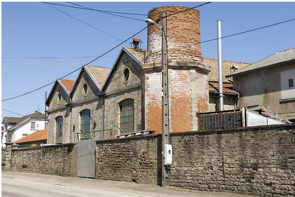
Salle des machines et base de la cheminée vues de trois quarts.
