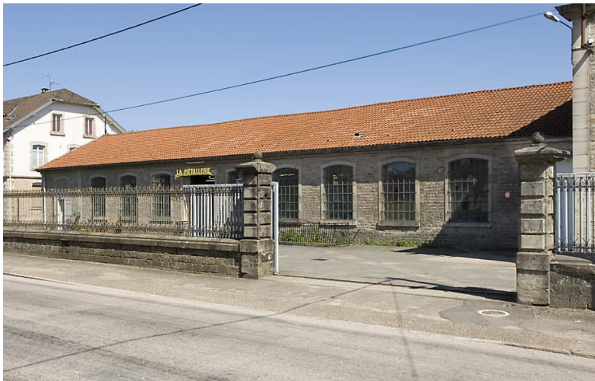
Cour et bâtiment nord en rez-de-chaussée. 70, Saint-Sauveur, 44 rue du Maréchal Lyautey
