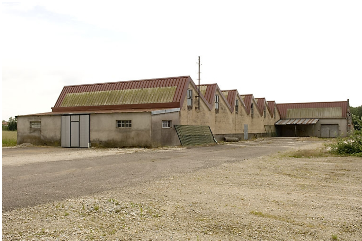
Atelier de fabrication (retorderie). Vue depuis le nord.
