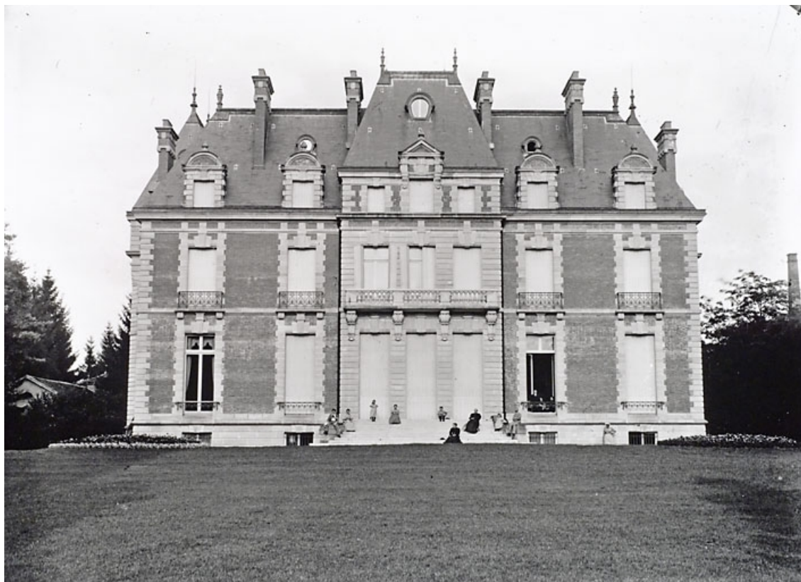
Façade occidentale de la nouvelle demeure patronale.
