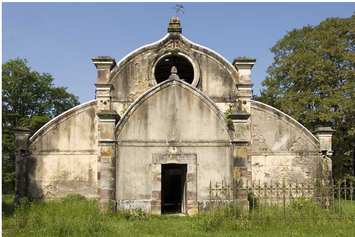
Serre. Mur-pignon est.
