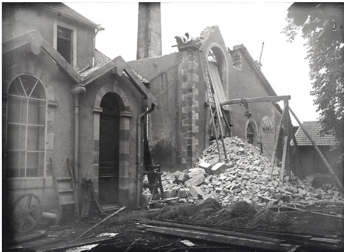
Démolition de l'ancienne filature (salle des machines ?).
