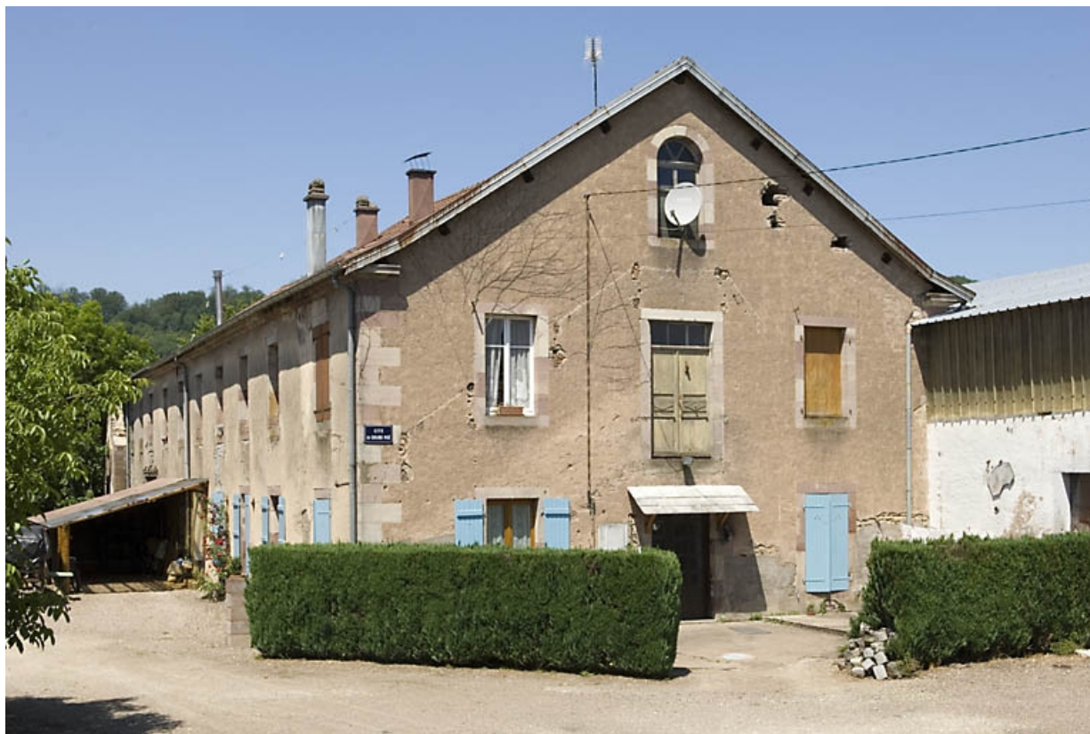
Atelier de fabrication. Vue depuis le sud-est. 70, Breuchotte rue du Grand Pré
