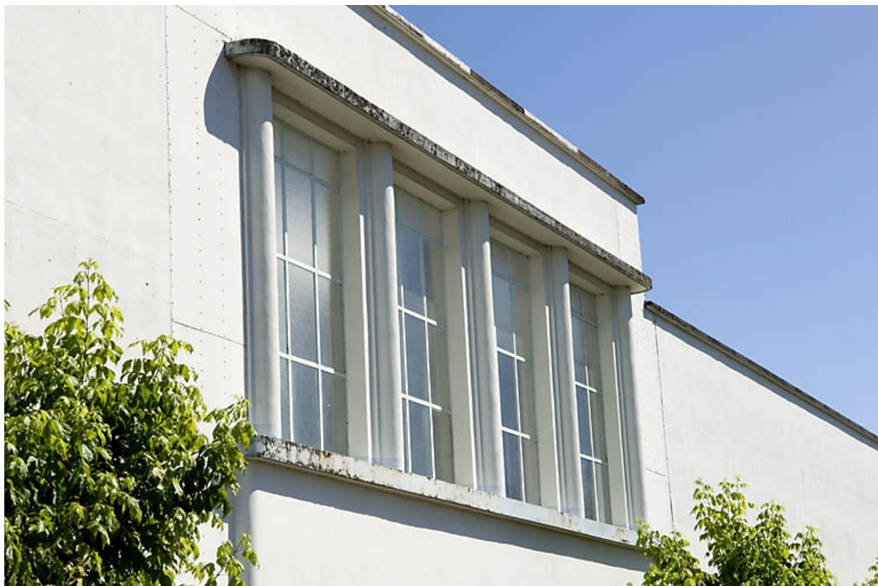
Façade sur rue des ateliers est. Détail d'une baie.
