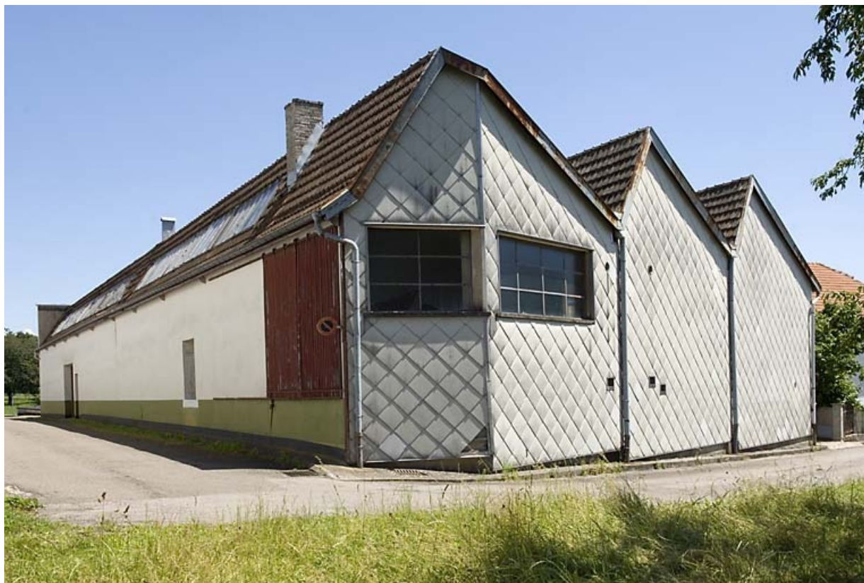
Bâtiments industriels. Vue depuis l'ouest.
