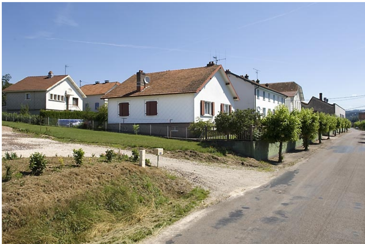
Logements. Vue d'ensemble depuis l'ouest.
