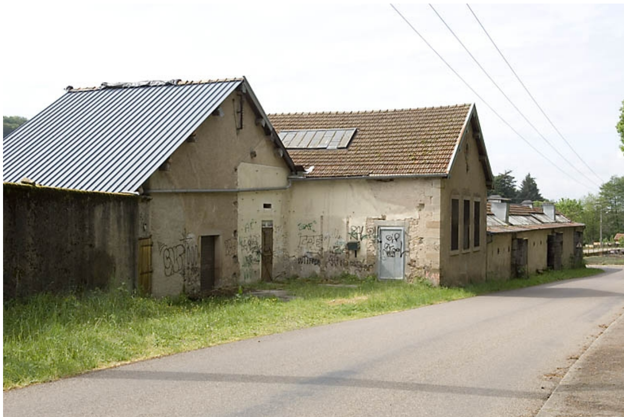
Salle des machines et façade nord des ateliers de fabrication.
