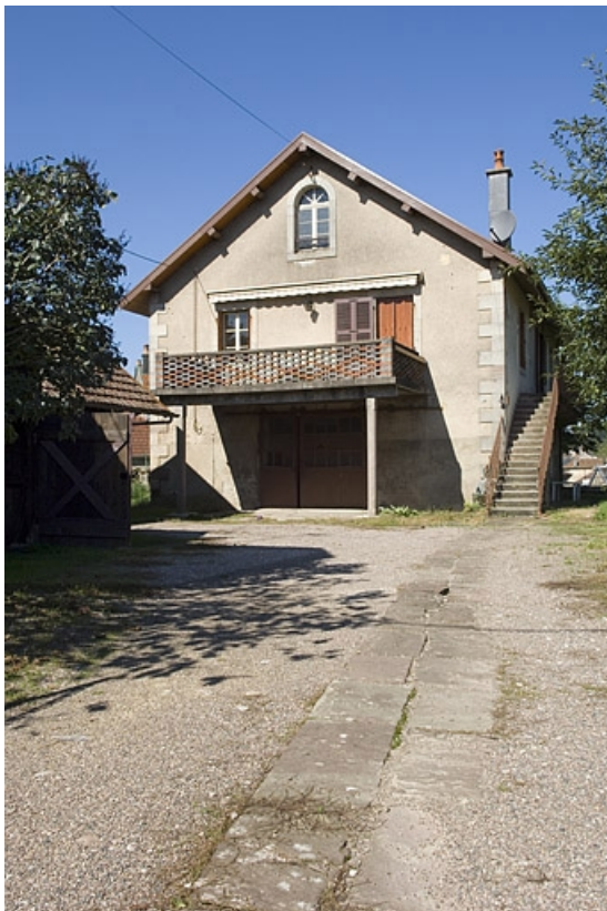
Vue d'ensemble depuis le sud.
