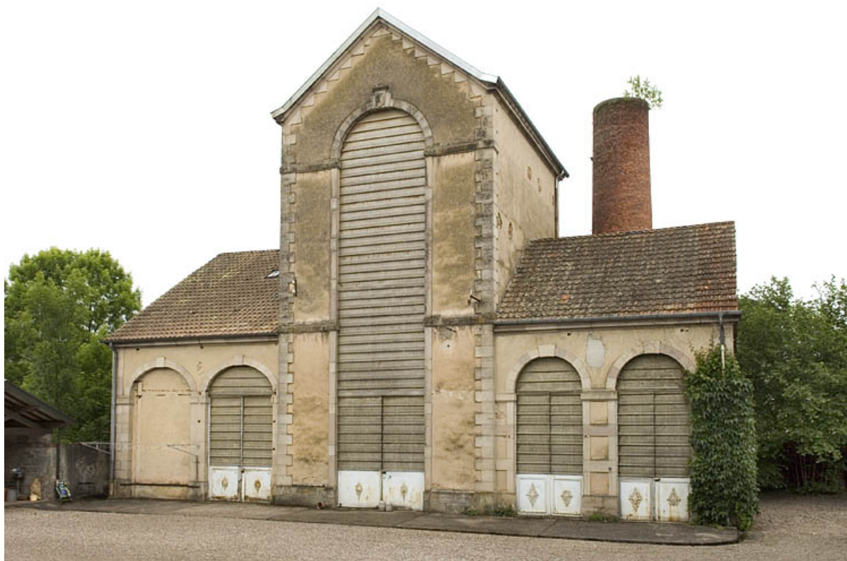
Bâtiment de rectification vu de face.
