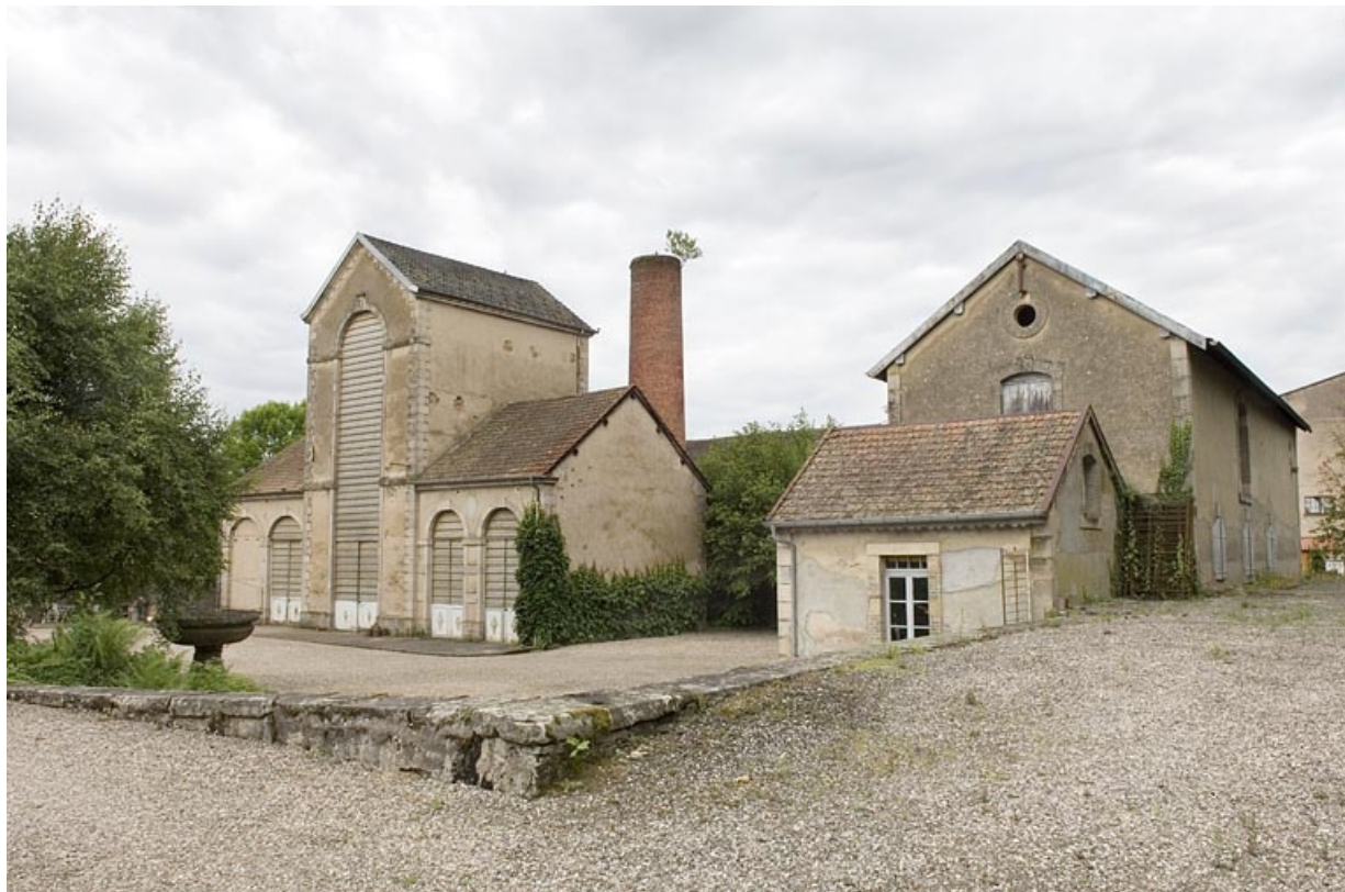
Bâtiment de rectification, bureau et entrepôt industriel.
