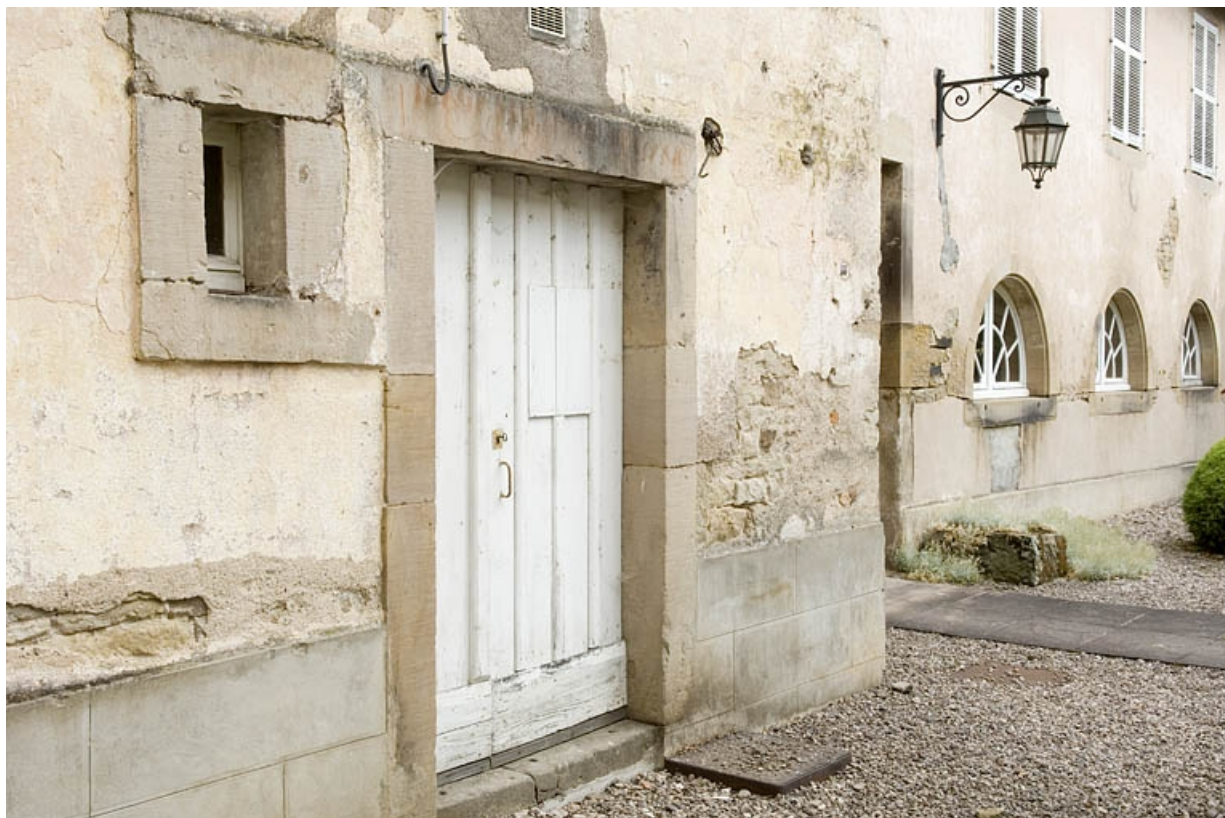
Détail de la façade de l'aile nord.
