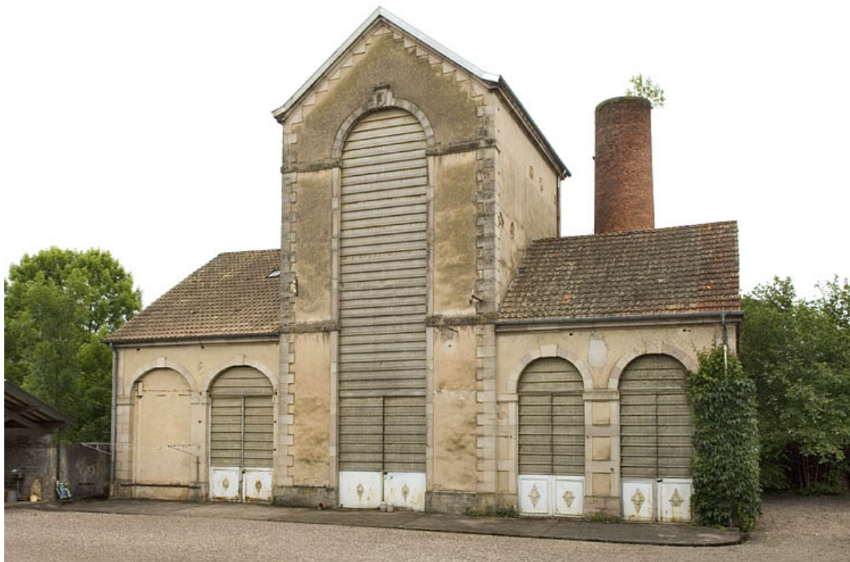
Bâtiment de rectification vu de face.
