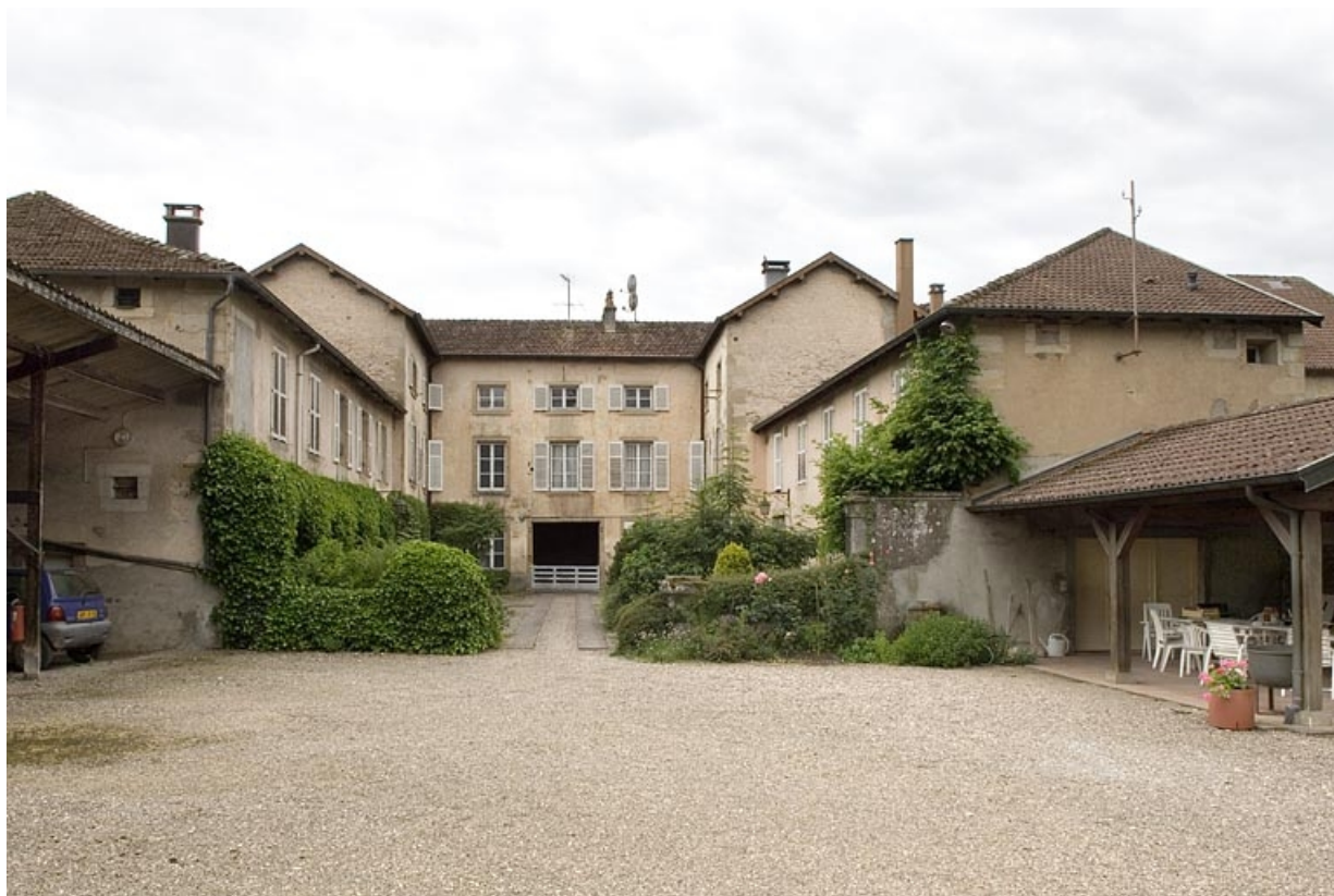
Le relais de poste vu depuis l'est.
