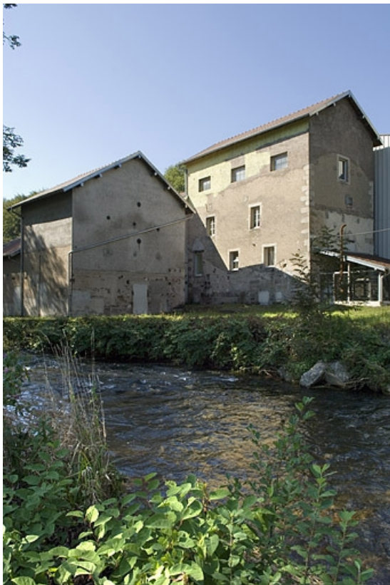
Élévation sud. Vue de trois quarts arrière.
