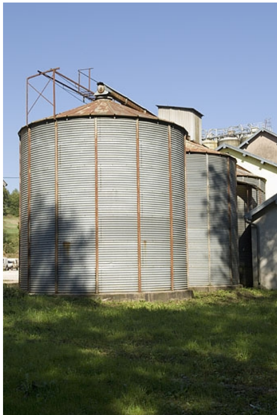
Silos métalliques. Vue depuis l'ouest.
