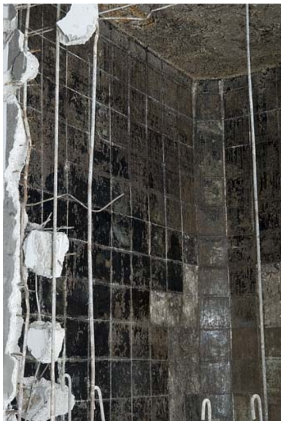
Détail d'une cuve en cours de démolition.
