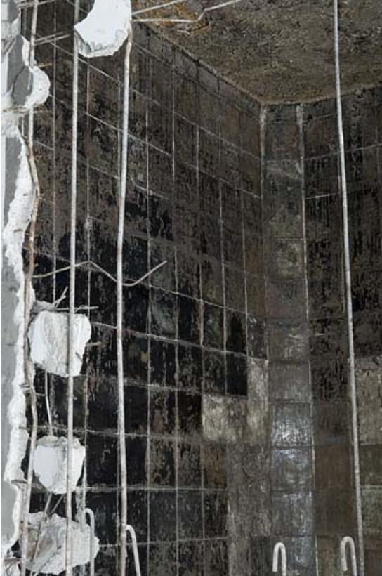
Détail d'une cuve en cours de démolition.
