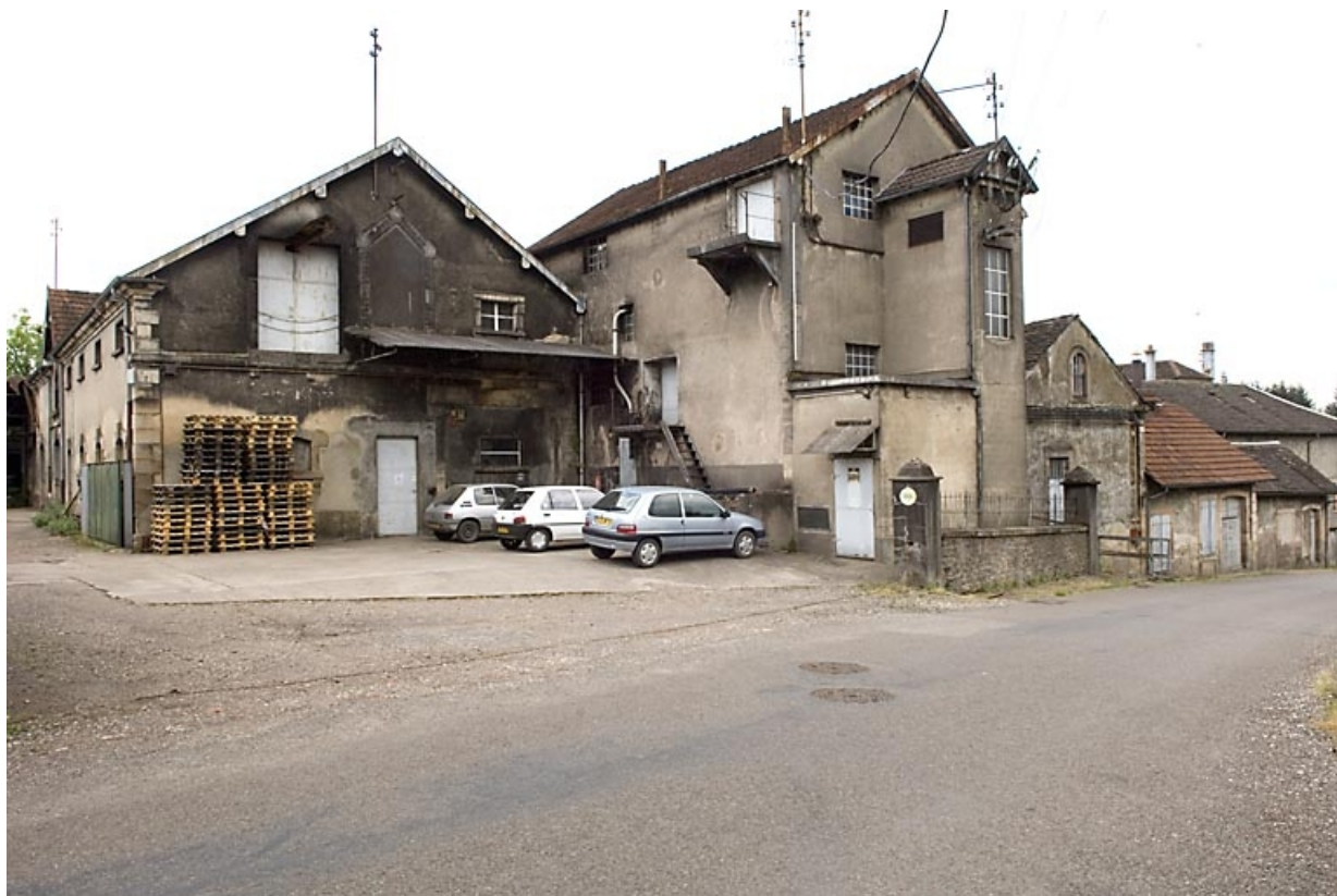
Ancienne écurie et cuverie. Vue depuis l'est. 70, Fougerolles, 32 rue de la Gare
