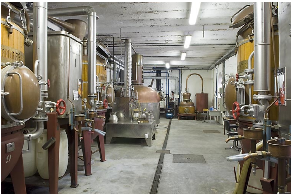
Atelier de distillation. Vue d'ensemble depuis le nord.
