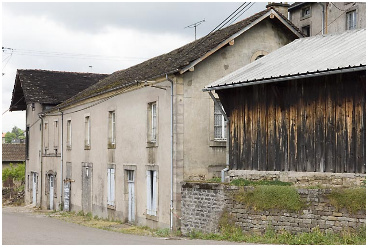
La menuiserie. Vue depuis le sud.
