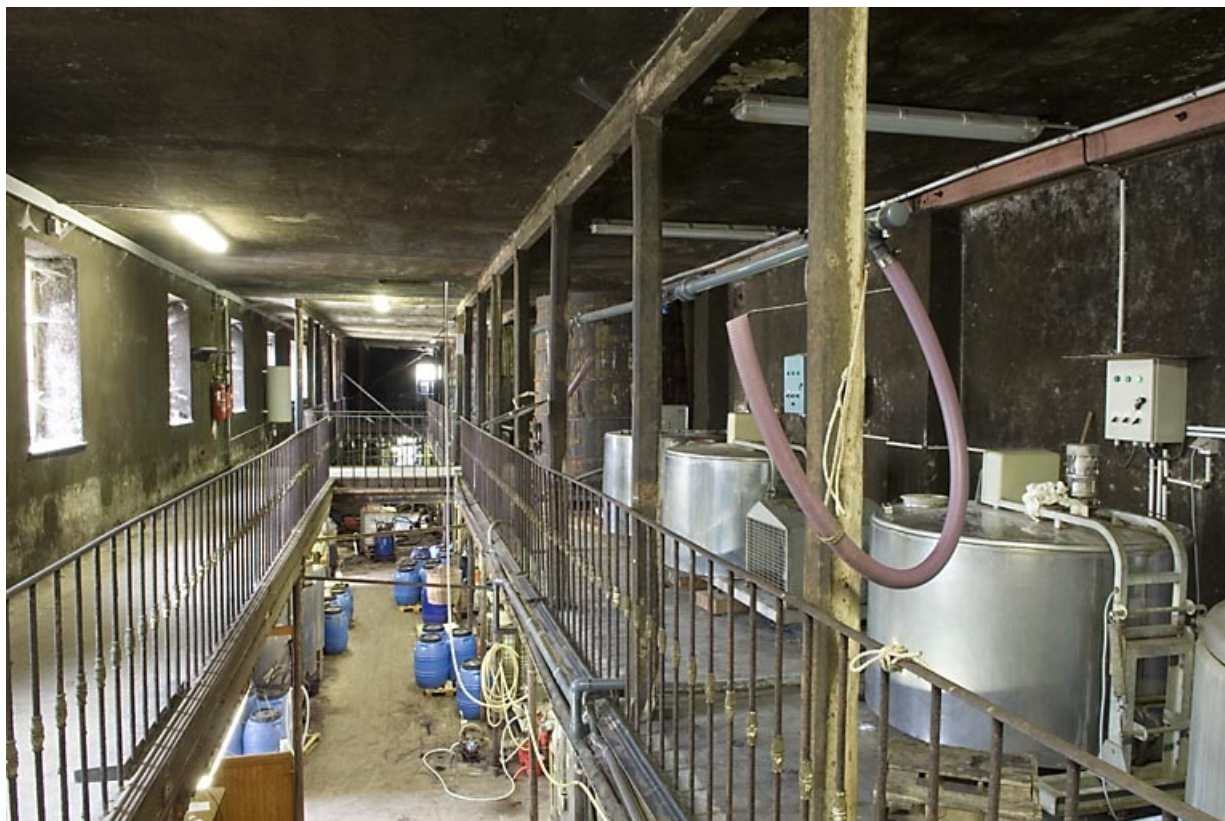
Etage de la cuverie. Vue d'ensemble.
