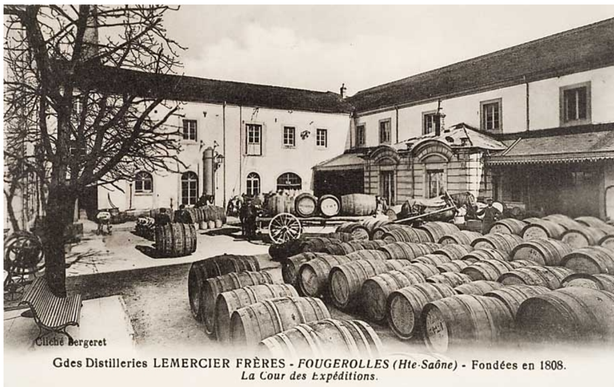
Grandes distilleries Lemerrier Frères. Fougerolles [...] La cour des expéditions.
