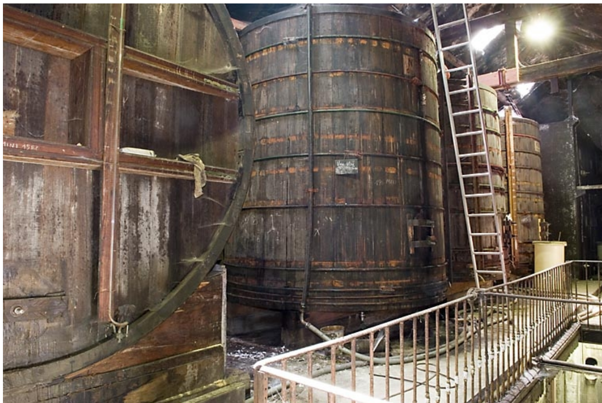
Etage de la cuverie. Alignement de foudres. 70, Fougerolles, 32 rue de la Gare
