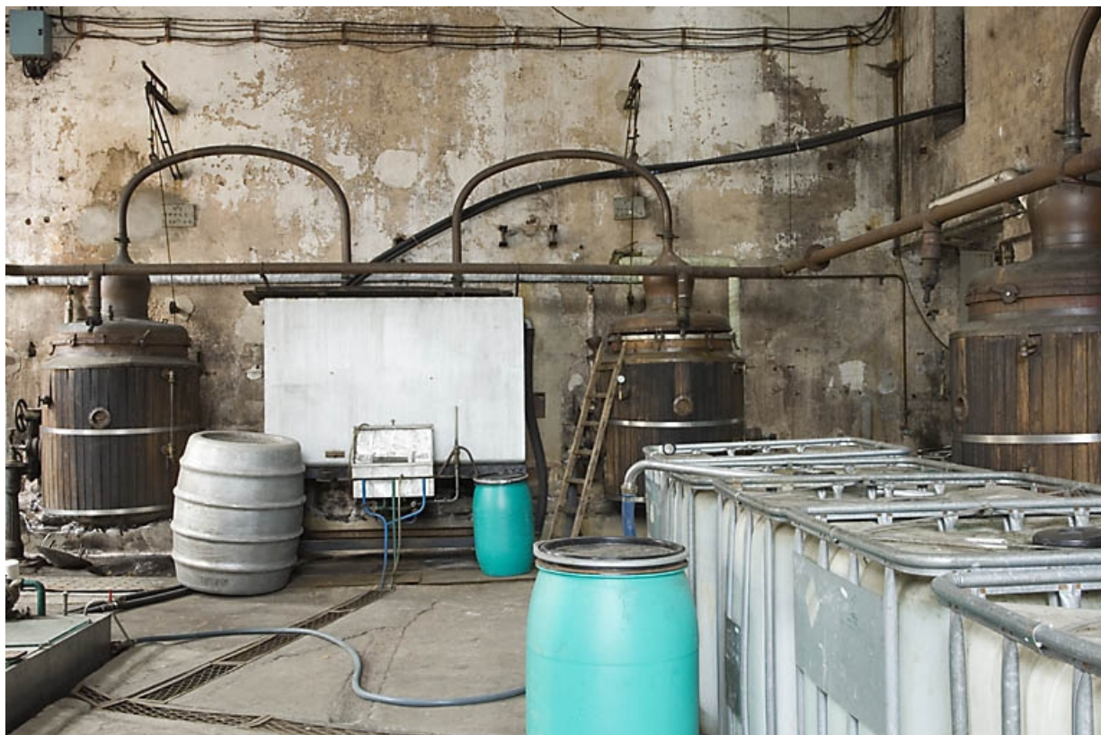
Ancien atelier de distillation. Vue d'ensemble. Alambics Egrot-Grangé. 70, Fougerolles, 43 avenue Claude Peureux
