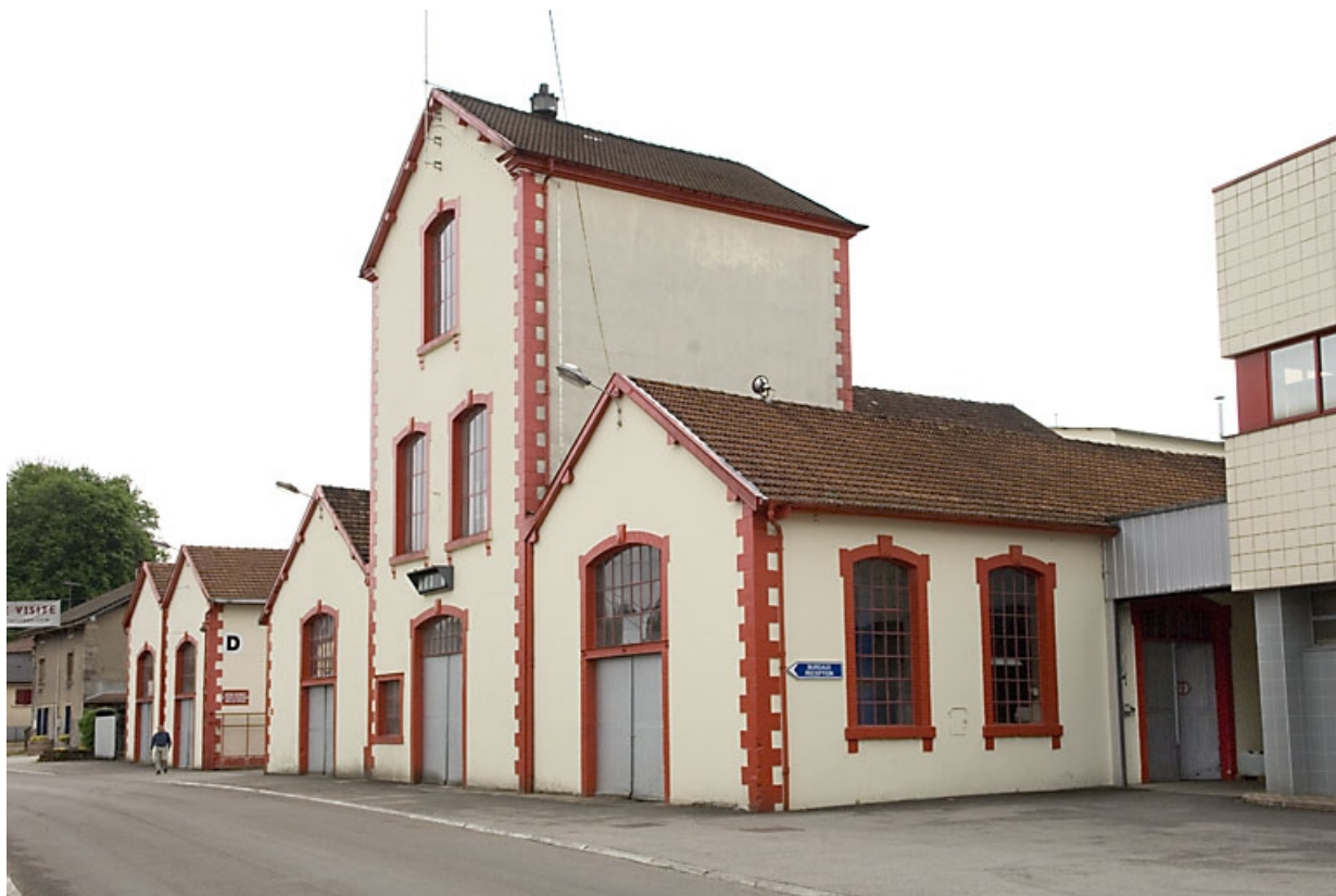
Atelier de réparation et de fabrication, et cuverie. Vue depuis l'ouest.
