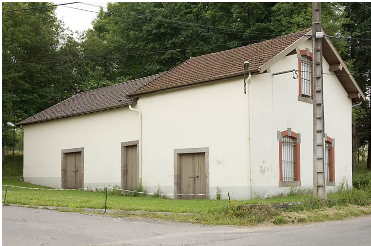
Ancien atelier de fabrication situé à l'est de la route départementale.
