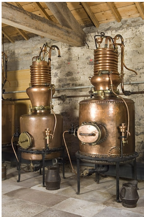
Deux alambics à vapeur provenant de la distillerie Lemerrier (Prédurupt). 70, Fougerolles, lieudit : le Petit Fahys
