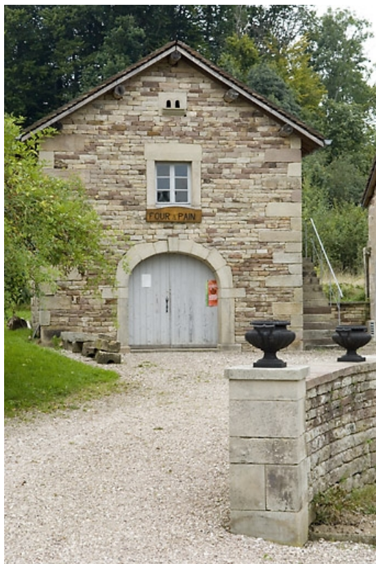
Four à pain. Vue de face.
