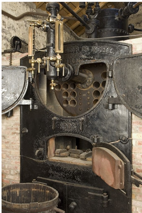
Chaudière Scheidecker et Kohl (Lure). Détail de la façade. 70, Fougerolles, lieudit : le Petit Fahys
