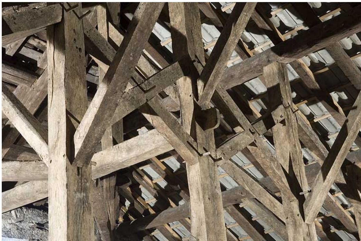
Charpente du fenil. Détail de partie haute.
