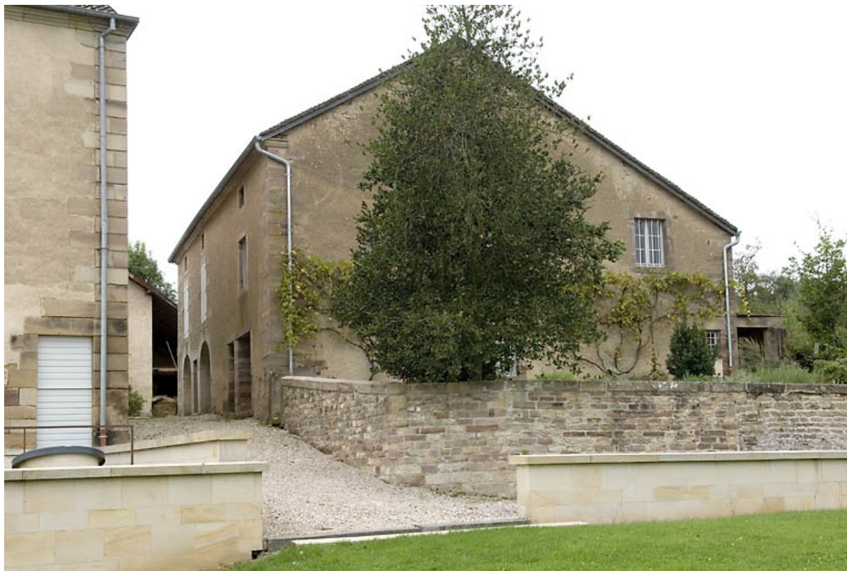
Atelier de distillation primitif. Vue depuis le sud-est.
