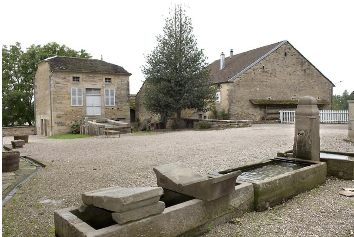
Grenier (à gauche) et fontaine dans la cour.
