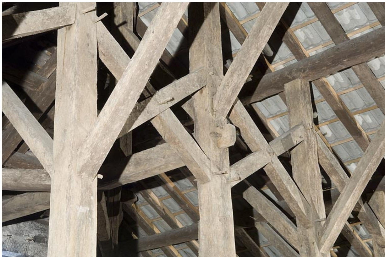
Charpente du fenil. Détail de partie haute (contrefiches et croix de Saint-André). 70, Fougerolles, lieudit : le Petit Fahys
