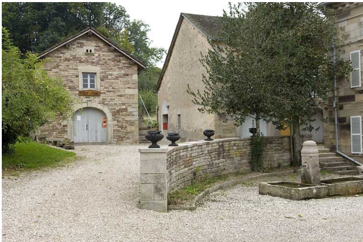
Four à pain et pignon de l'atelier de distillation primitif.
