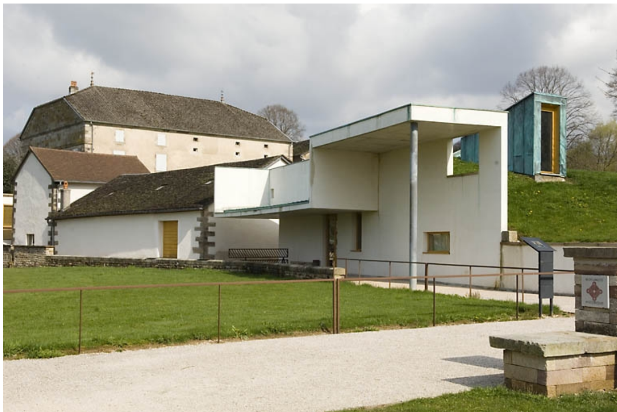
Vue d'ensemble de l'Ecomusée depuis l'entrée.
