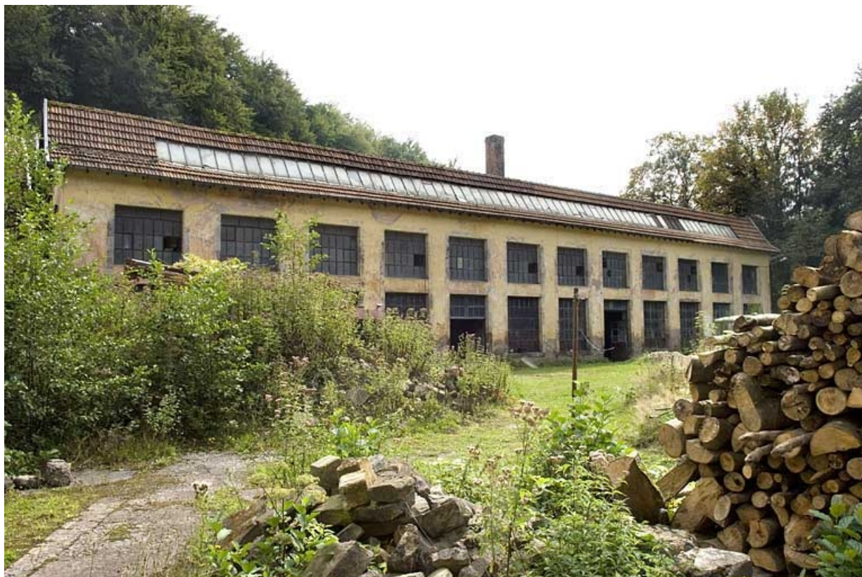
Façade occidentale de l'atelier de fabrication.
