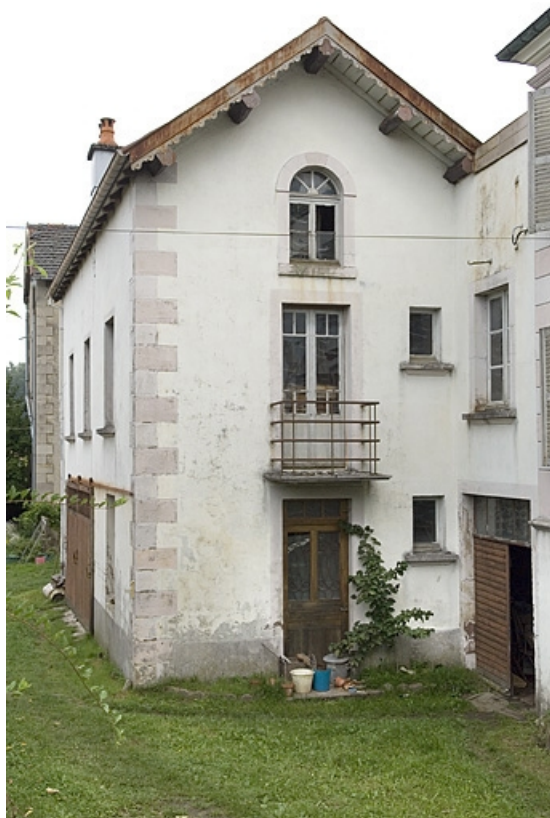
Garage, écurie et logement. Pignon du bâtiment.
