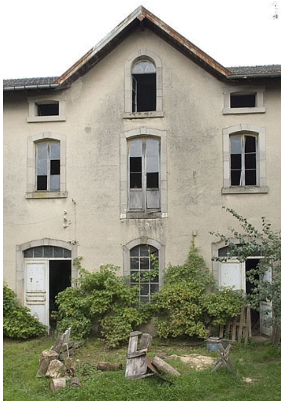
Atelier de distillation. Détail de la façade antérieure.
