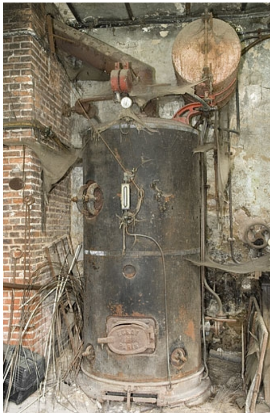
Atelier de distillation. Chaudière Egrot.
