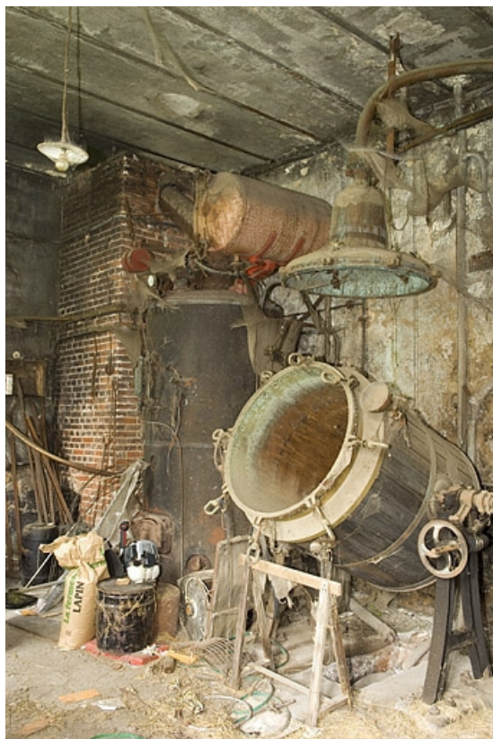
Atelier de distillation : base de la cheminée, chaudière et alambic Egrot et Grangé. 70, Aillevillers-et-Lyaumont, 1 rue de la Gare
