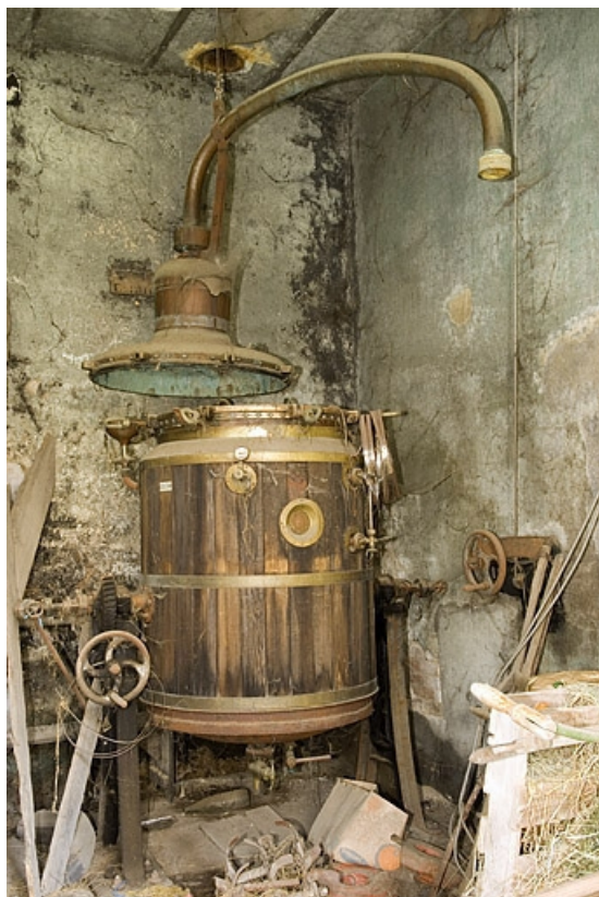
Atelier de distillation. Alambic Deroy Fils Aîné (angle sud-est). 70, Aillevillers-et-Lyaumont, 1 rue de la Gare
