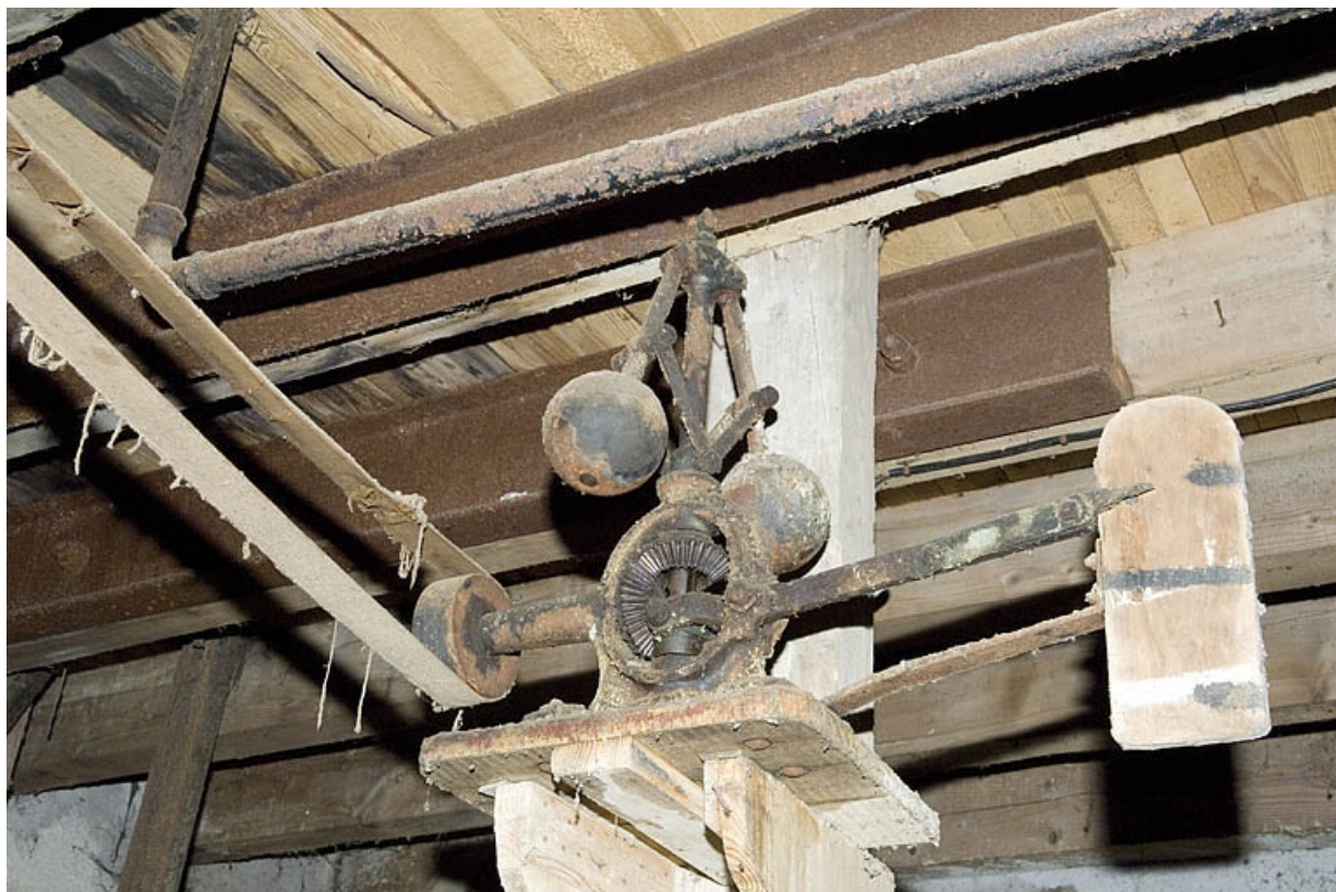
Régulateur à boules du système de transmission de la de la turbine.
