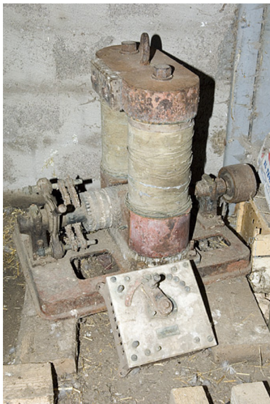
Moteur électrique Edison et tableau électrique.
