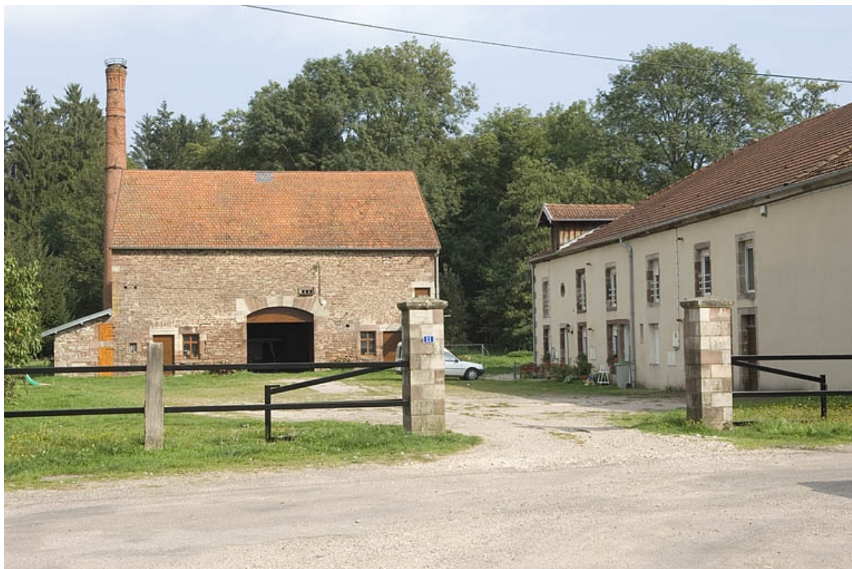
Atelier de fabrication (fabrique de colle) et façade nord de l'entrepôt industriel. 70, Corbenay rue de la Féculerie, lieudit : les Naues
