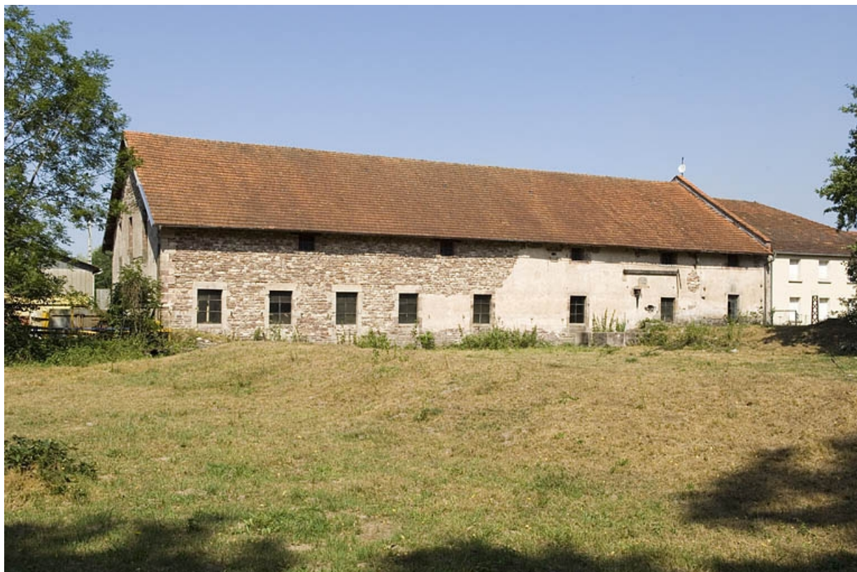
Bâtiment abritant la salle des tables, le séchoir, le magasin industriel et le bâtiment d'eau.
