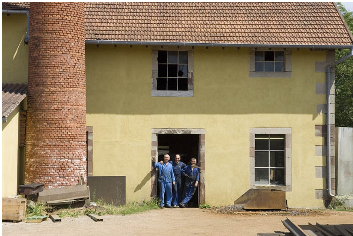
Extrémité sud de la salle des tables et du séchoir.
