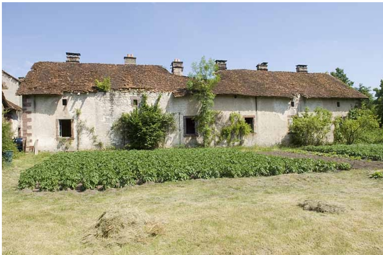
Façade postérieure du logement ouvrier.
