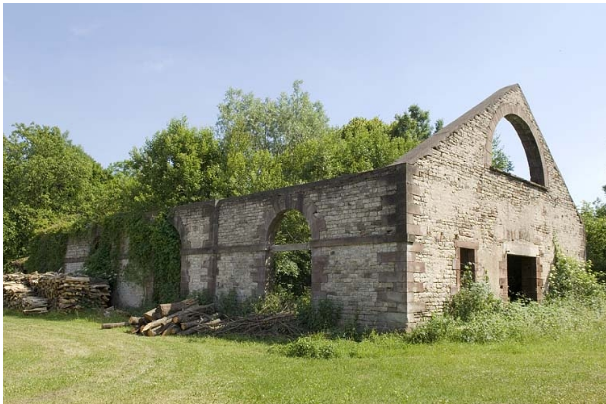
Atelier du laminier (en ruines). Vue de trois quarts droite.
