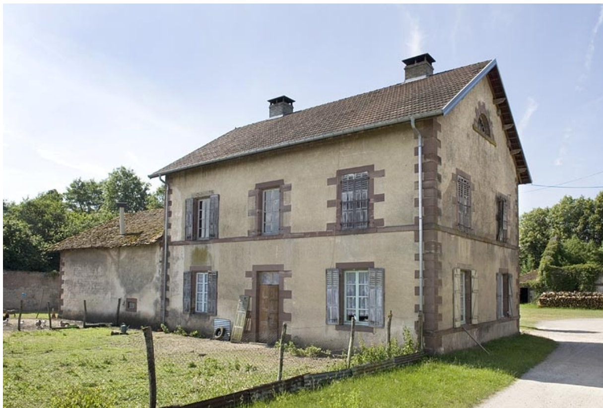
Pavillon est depuis le chemin d'accès.
