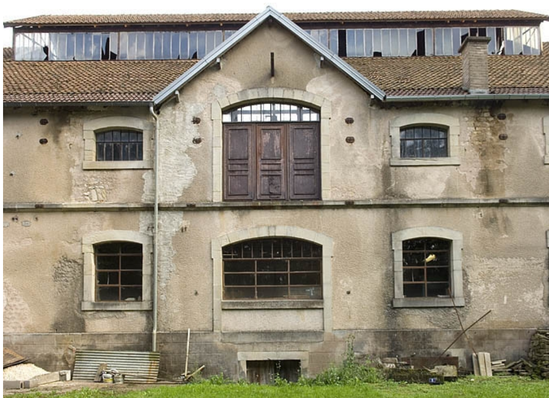
Travée centrale de la façade postérieure.
