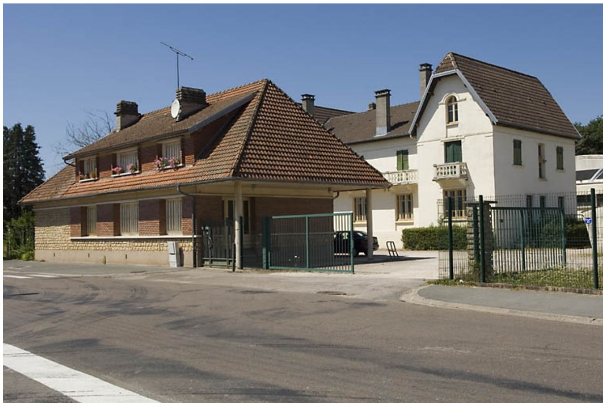
La conciergerie et le bâtiment des bureaux et du logement.
