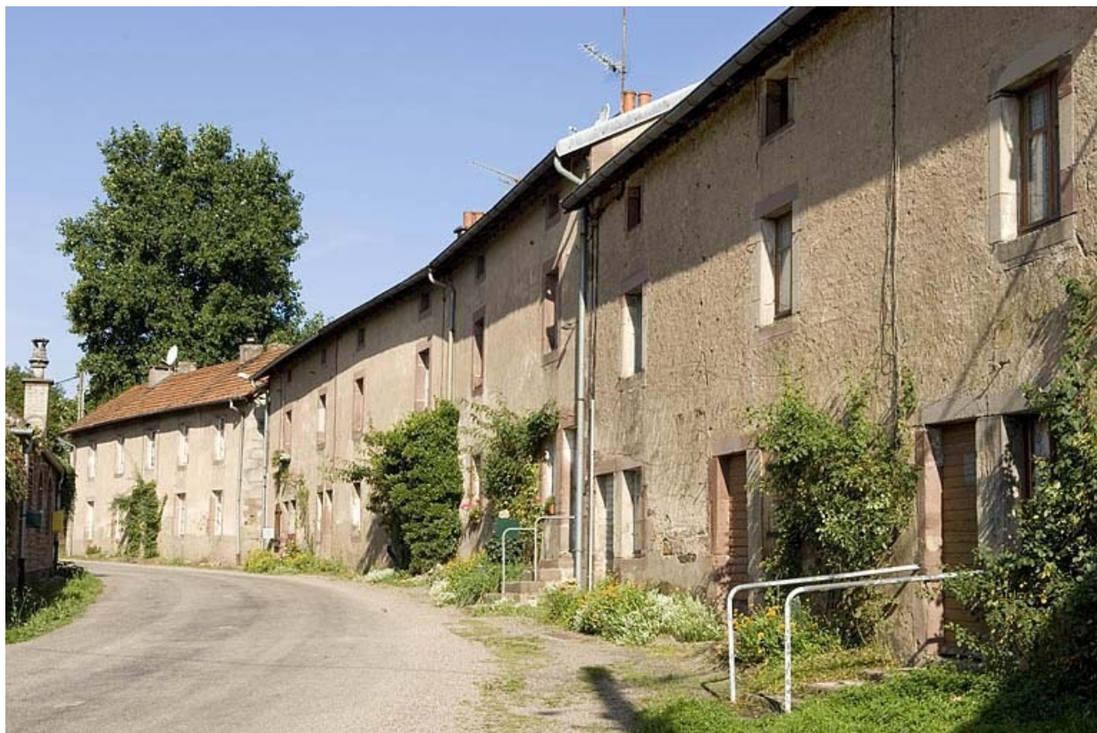
Façades de logements ouvriers (R.D. 304). 70, Hautevelle, lieudit : le Beuchot
