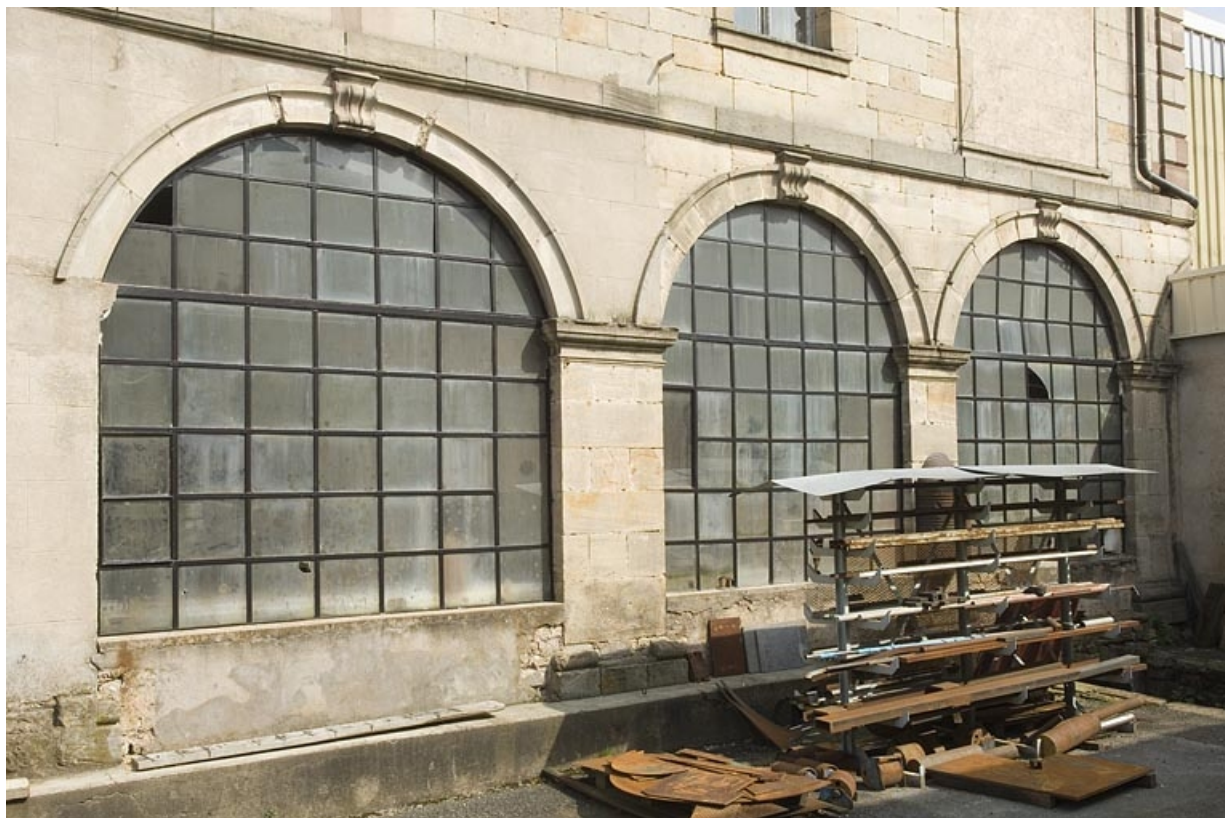
Bâtiment prieural. Baies de la façade ouest.
