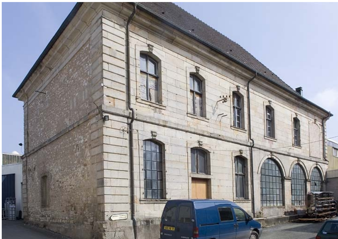
Bâtiment prieural (puis atelier de fonderie de cuivre). Façade ouest.
