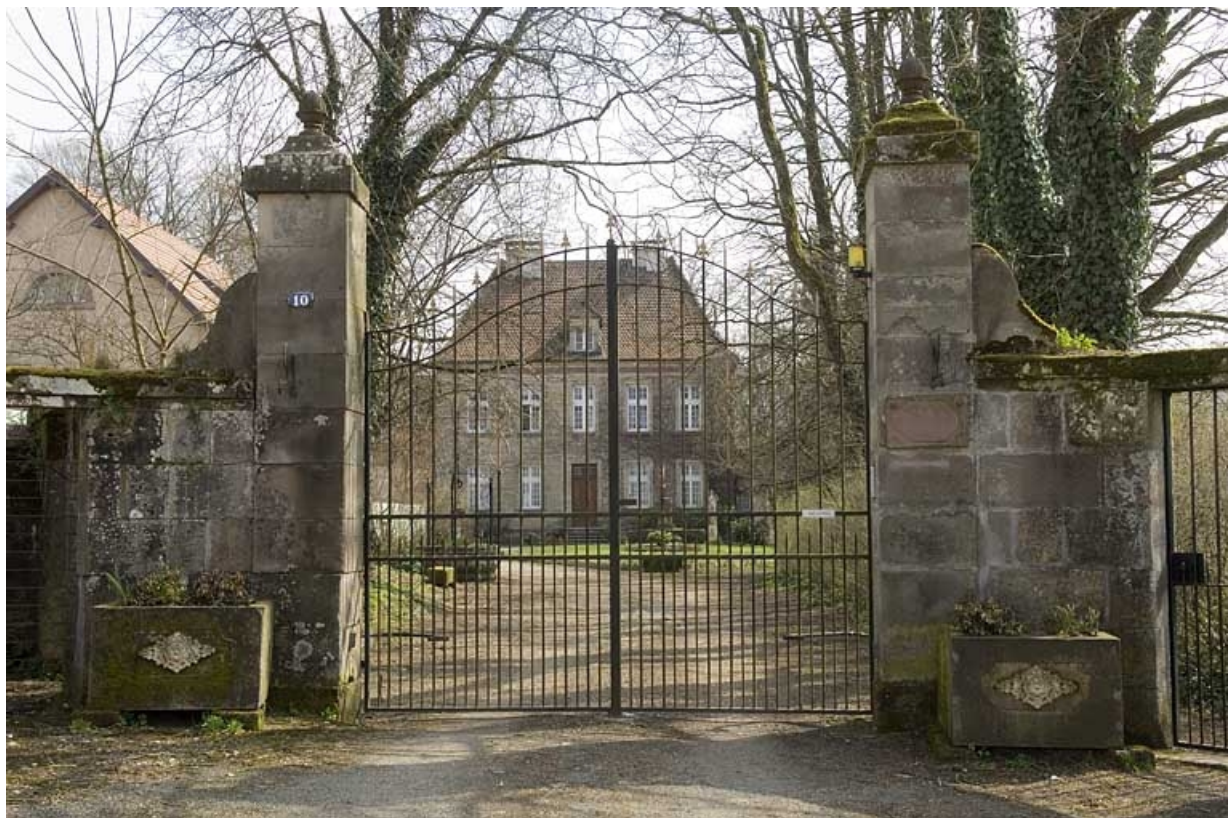
Demeure prieurale (puis logement patronal). 70, Fontaine-lès-Luxeuil, 14 rue Marquiset
