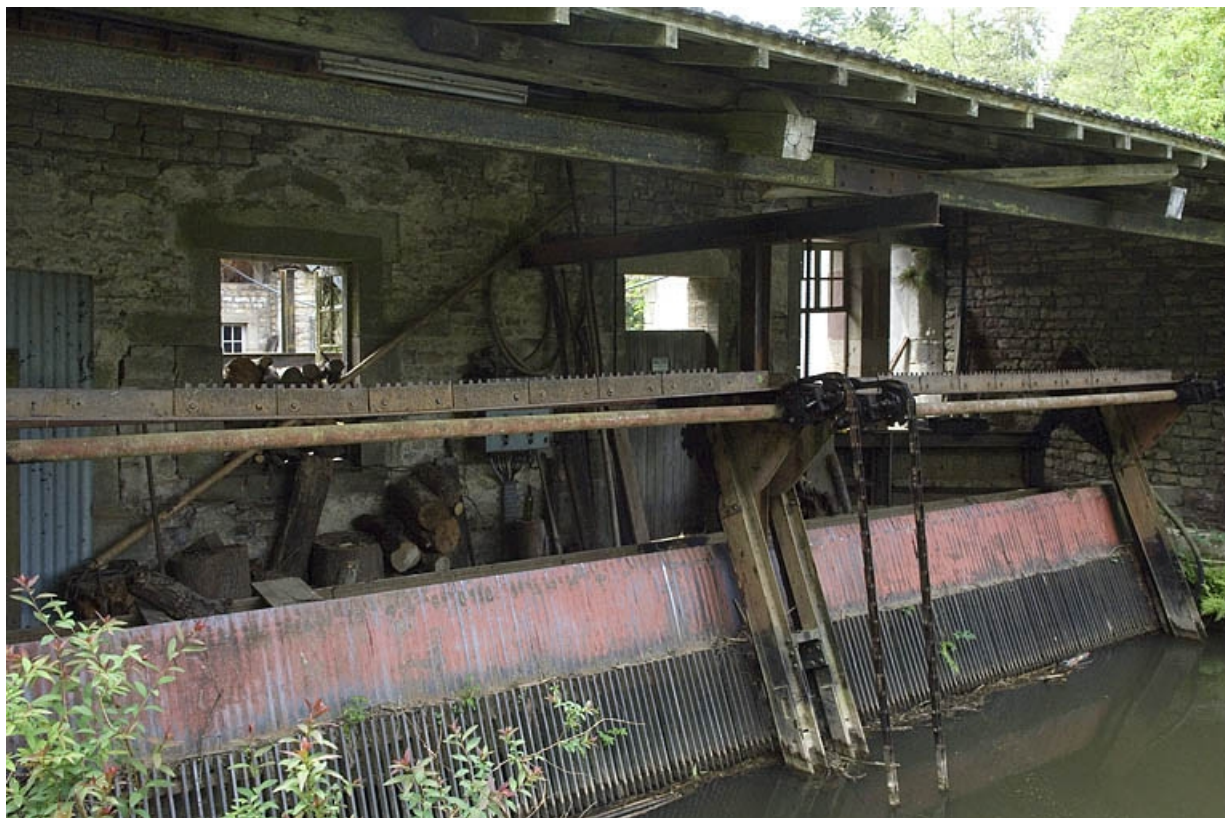
Grille de nettoyage à l'extrémité du bief d'aménée.
