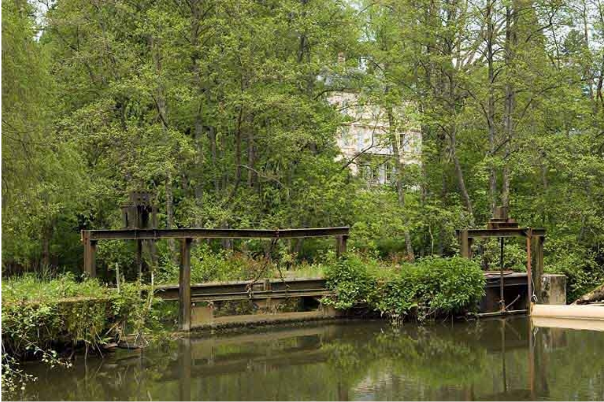
Vannage sur le bief d'amenée.
