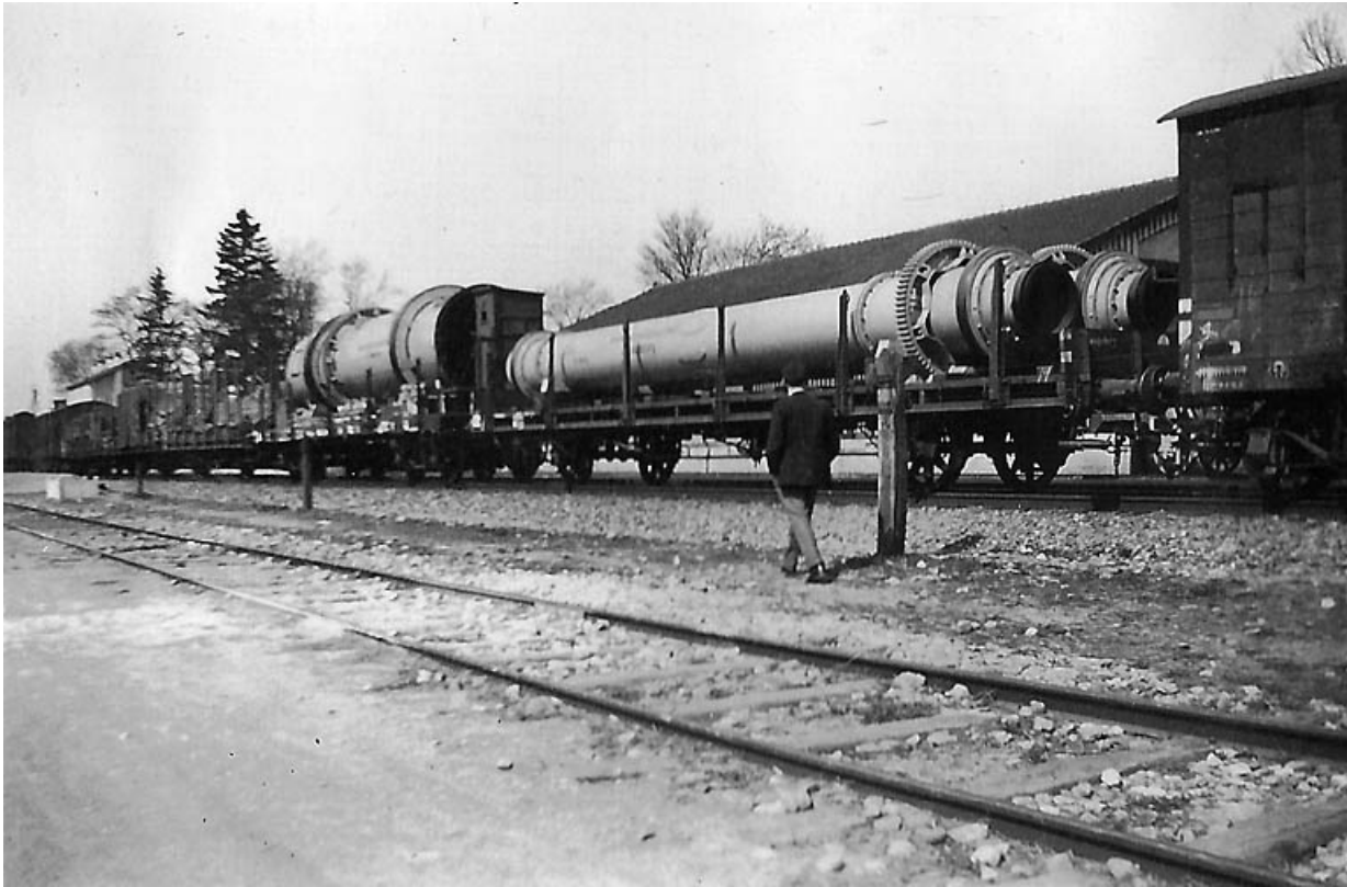
Arrivée en gare de Creveney du séchoir et du four.
