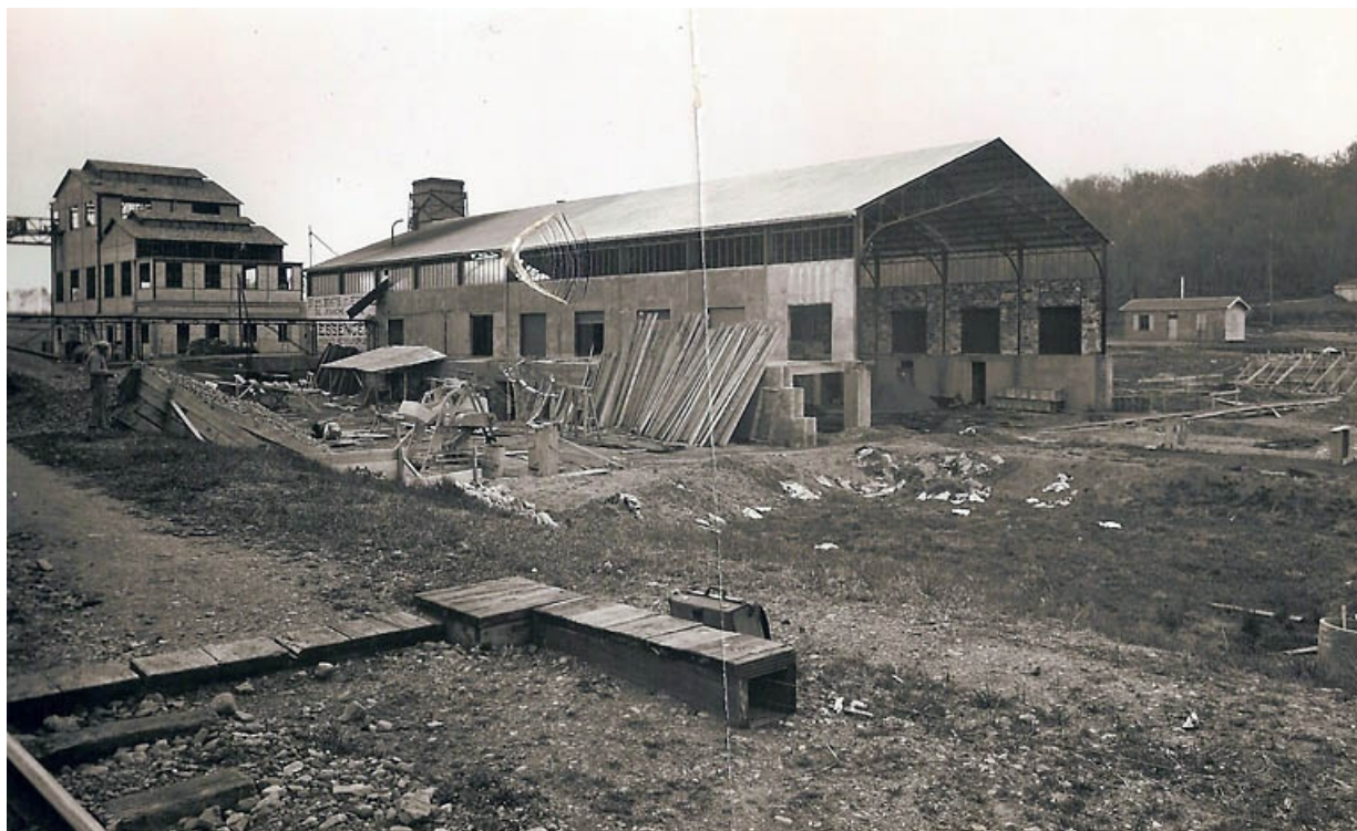
Vue d'ensemble depuis la gare.
