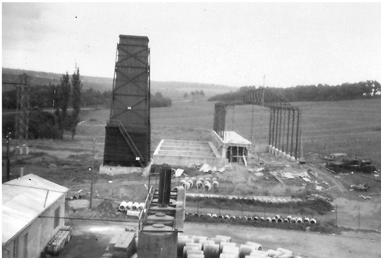
Tour de réfrigération et raffinerie en construction.
