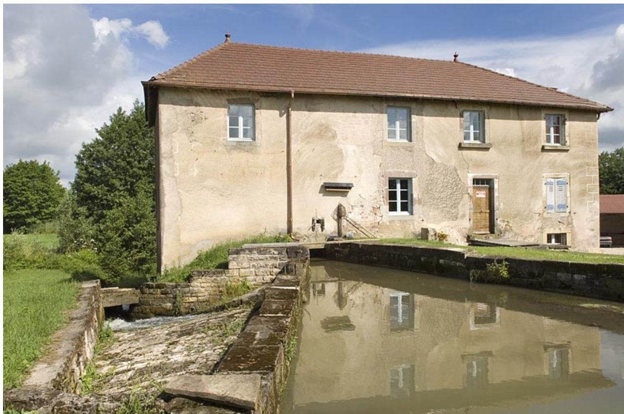
Le canal d'amenée et le moulin depuis le sud.
