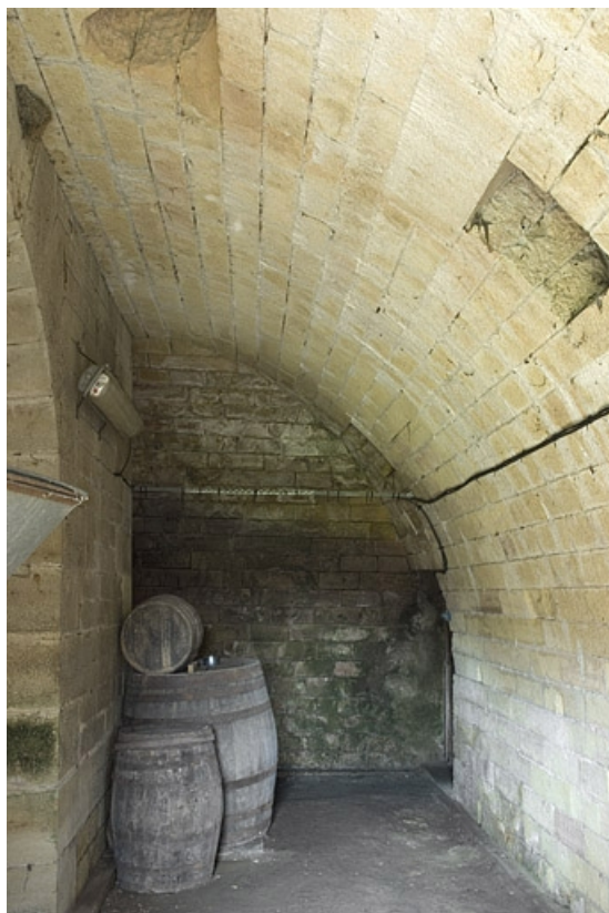
Couloir de circulation voûté d'un demi-berceau.
