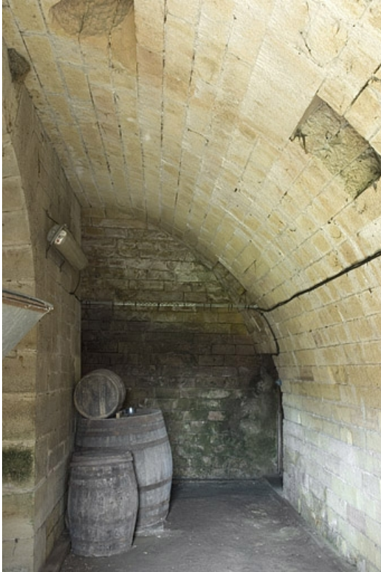
Couloir de circulation voûté d'un demi-berceau.
