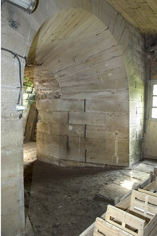
Détail d'une embrasure et de son appareillage.
