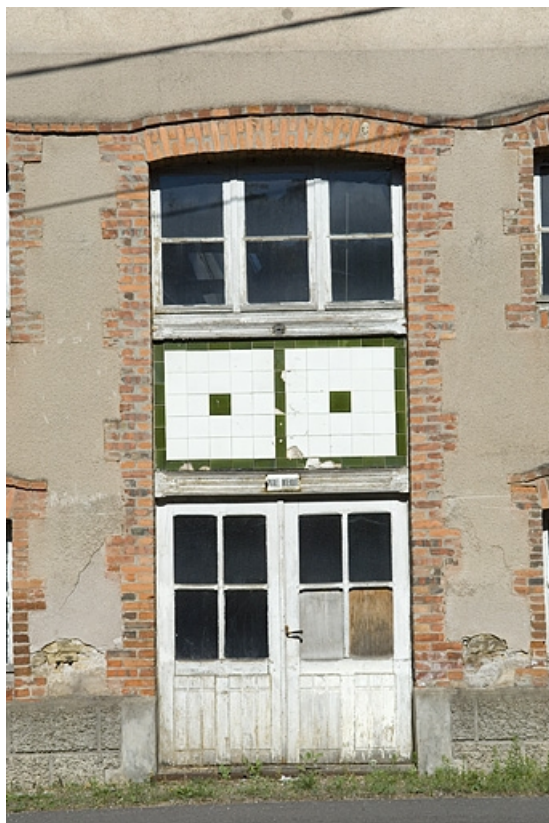
Façade sur rue. Détail de la travée centrale. 70, Neurey-en-Vaux R.D. 10
