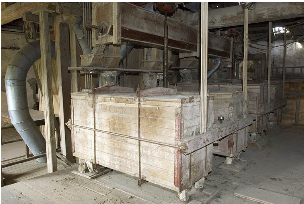
Vue d'ensemble des plansichters (3e étage). 70, Villers-lès-Luxeuil, lieudit : moulin du Teux
