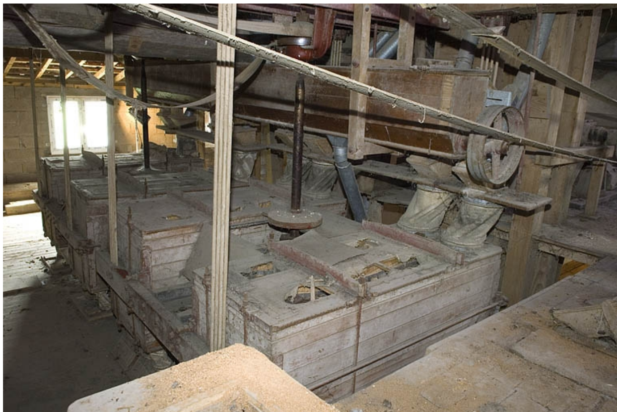
Vue plongeante sur les plansichters (3e étage).
