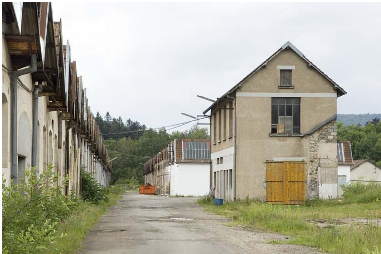
Ateliers de fabrication et transformateur depuis le nord-est. 70, Plancher-les-Mines rue du Pont du Var
