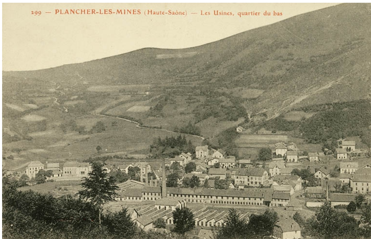
Plancher-les-Mines (Haute-Saône)- Les Usines, quartier du Bas.
