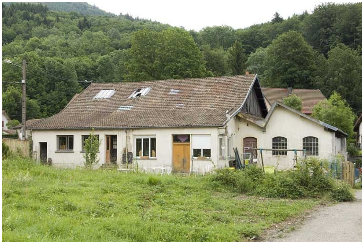
Atelier de réparation (entretien général). 70, Plancher-les-Mines rue du Pont du Var
