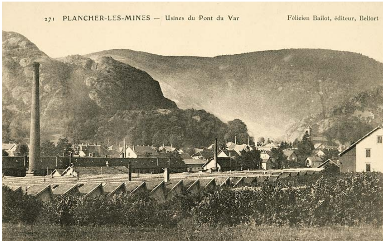
Plancher-les-Mines - Usines de Pont du Var.
