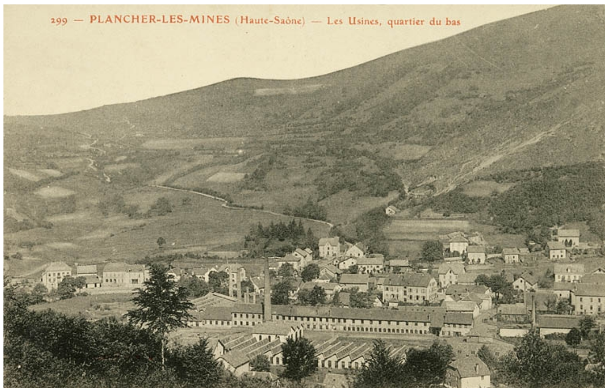
Plancher-les-Mines (Haute-Saône)- Les Usines, quartier du Bas.
