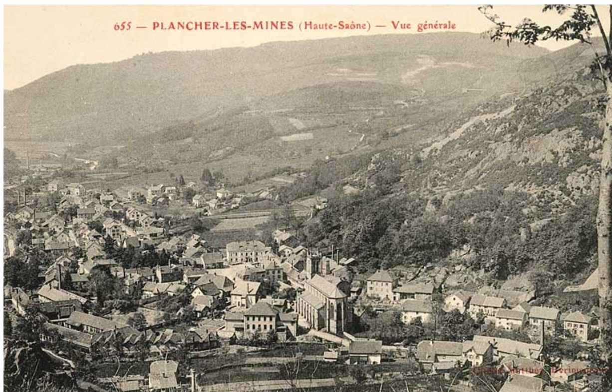
Plancher-les-Mines (Haute-Saône) - Vue générale.
