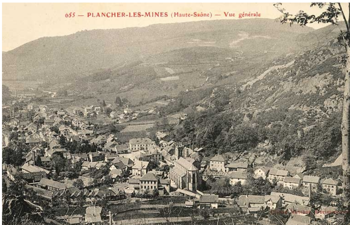
Plancher-les-Mines (Haute-Saône) - Vue générale.
