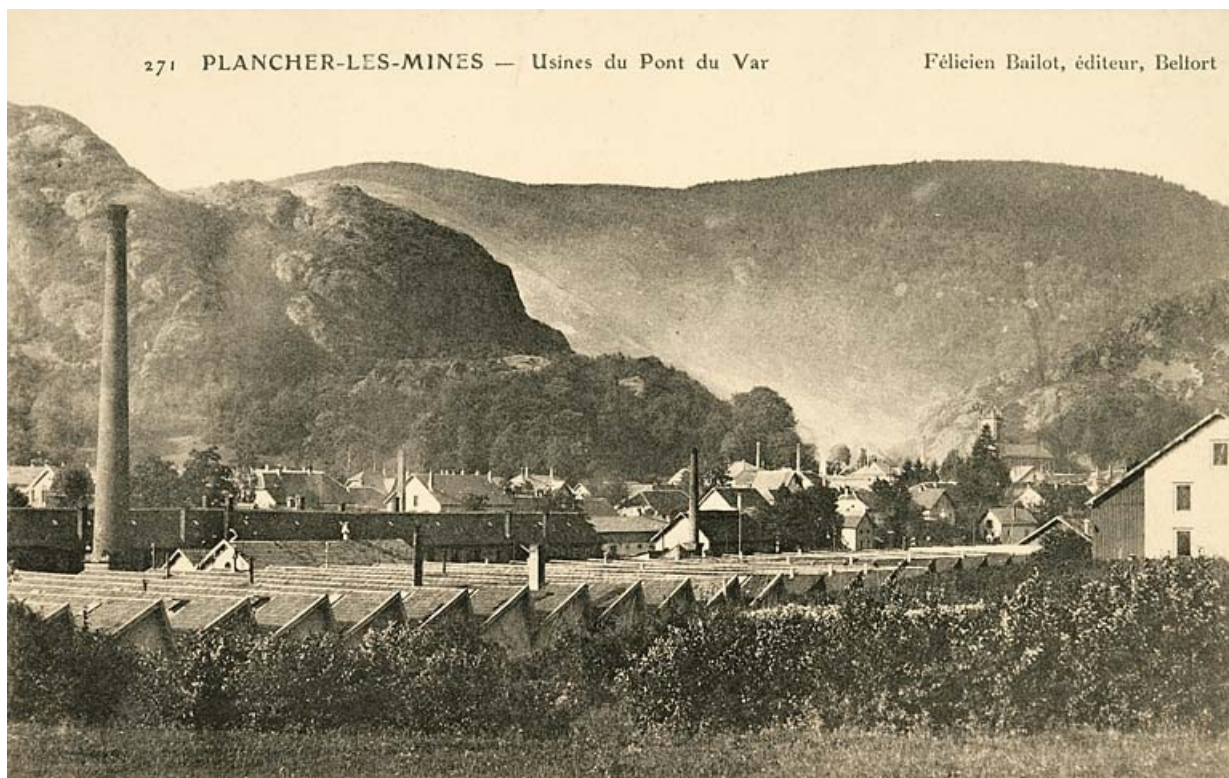
Plancher-les-Mines - Usines de Pont du Var.
