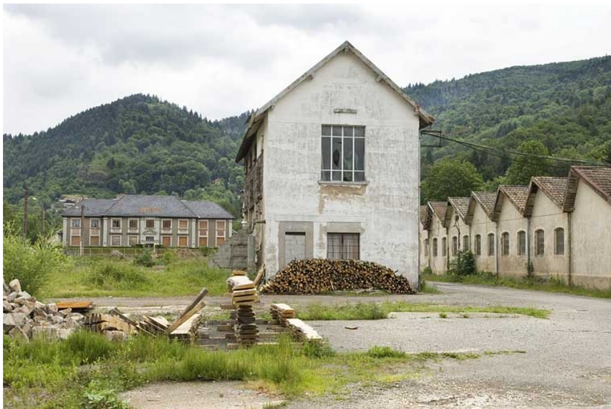
Bureaux, transformateur et atelier de fabrication depuis le sud-ouest.
