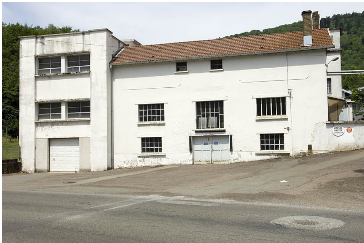
Façade sur la rue de France.
