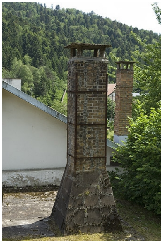
Détail d'une cheminée.
