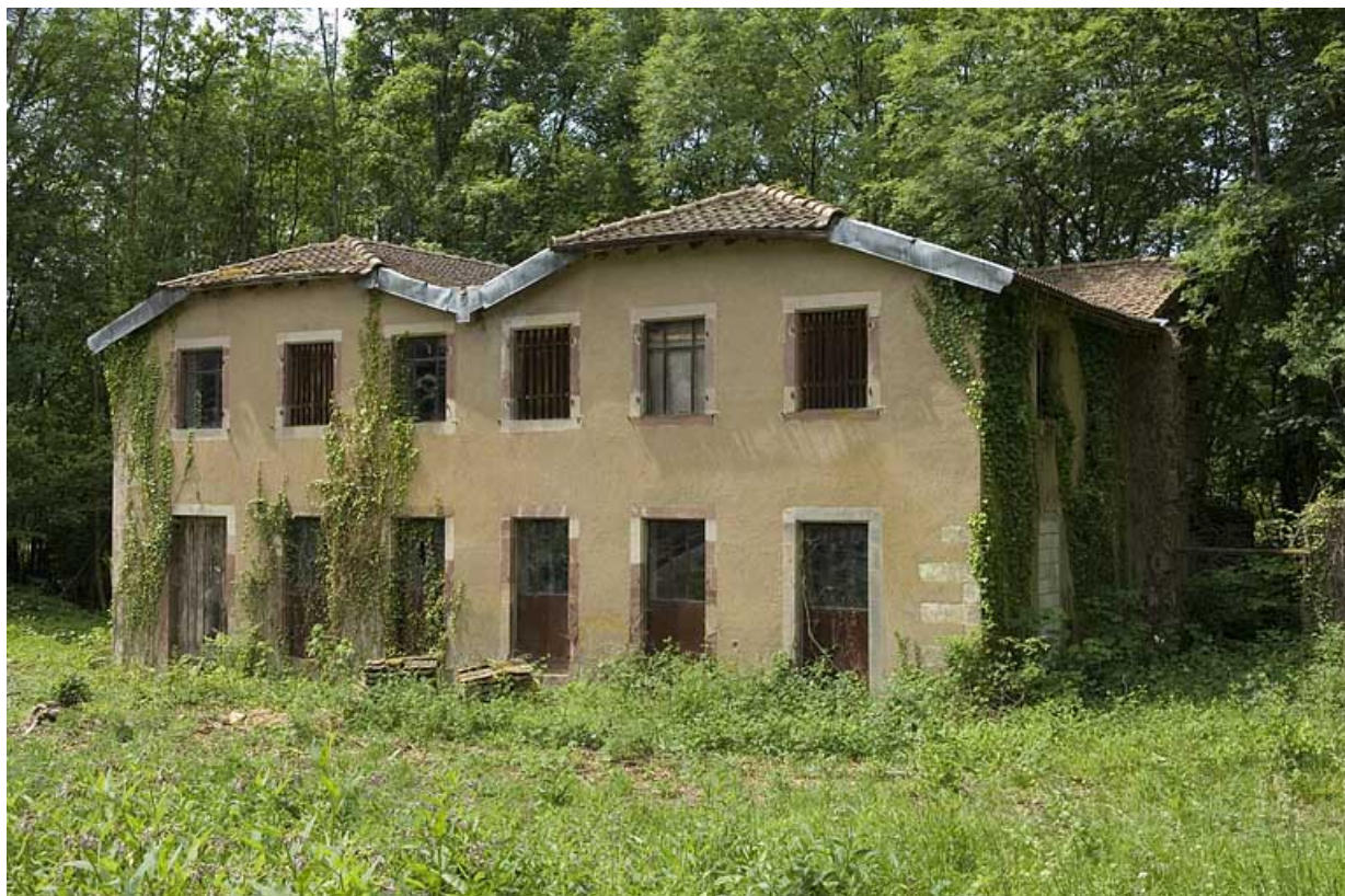
Bâtiment à usage indéterminé (logement, bureau ?).
