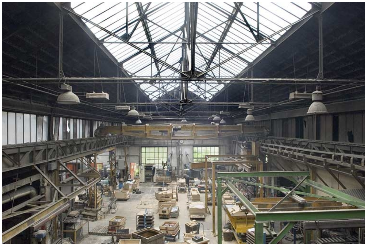
Vue intérieure de l'atelier de fonderie au sable (cadrage horizontal). 70, Plancher-Bas, 56 rue Louis Pasteur
