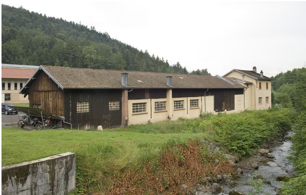
Façade ouest de l'ancien atelier de modelage et du logement.
