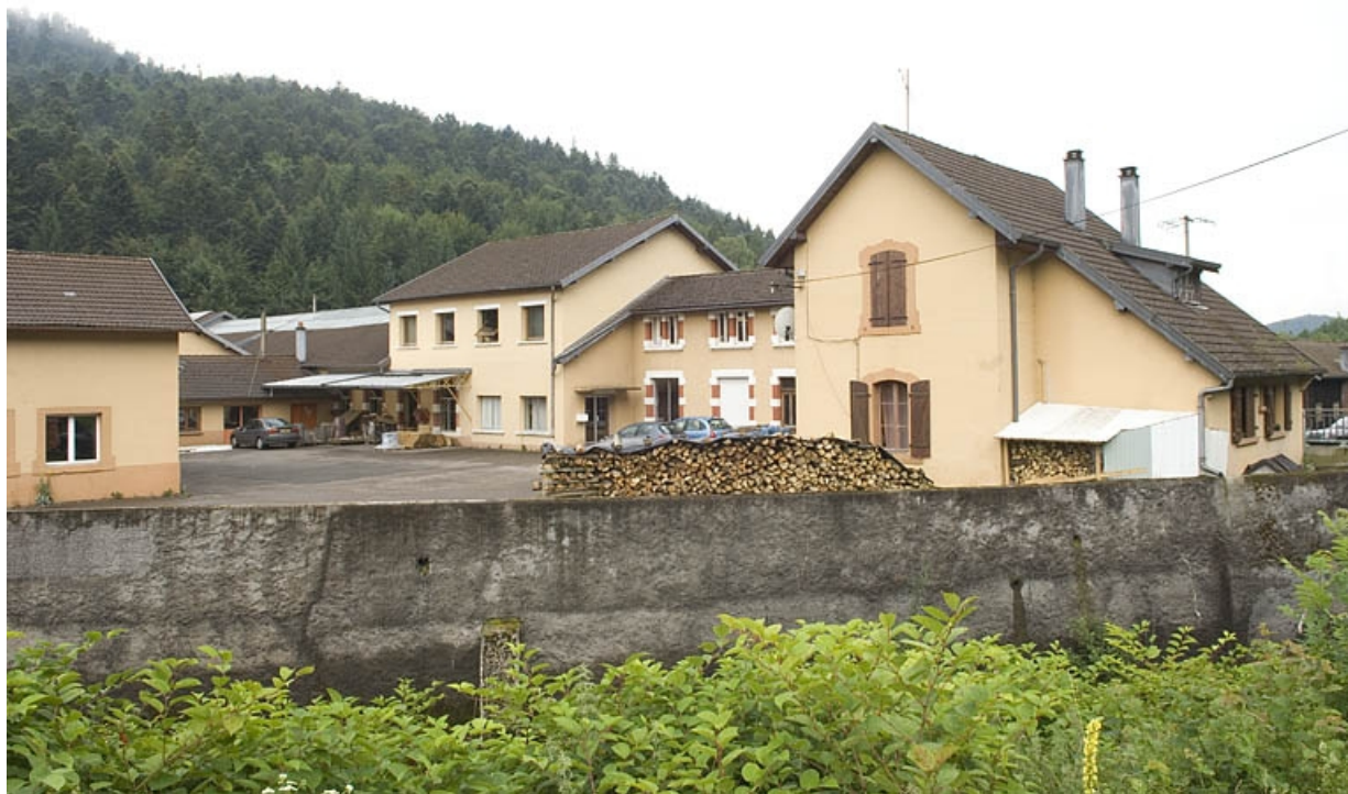
Bureaux et conciergerie depuis la rive droite.
