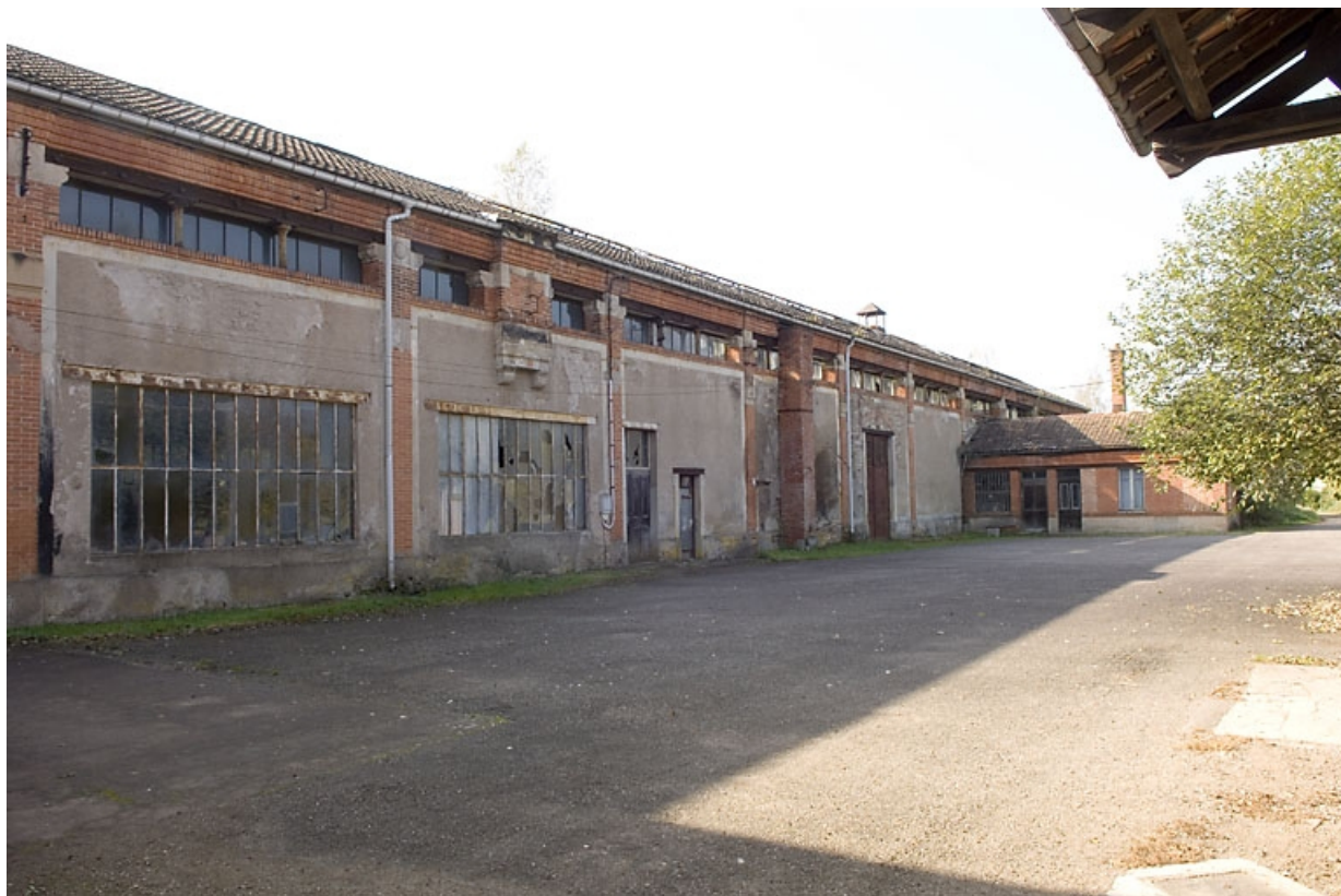
Façade antérieure depuis l'est.
