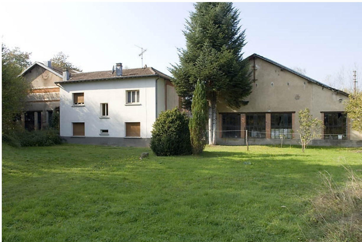
Façades postérieures depuis l'est.
