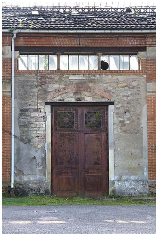
Façade antérieure. Détail d'une travée.
