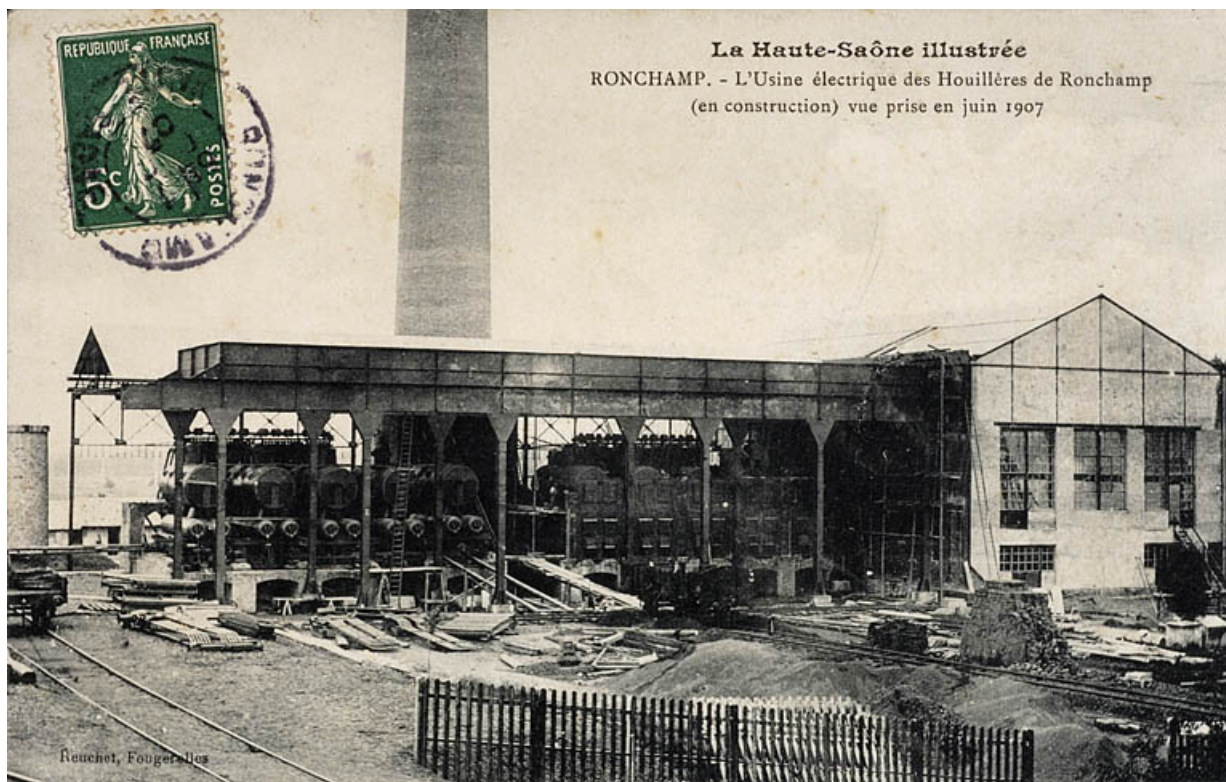
La Haute-Saône illustrée. Ronchamp. - L'usine électrique des Houillères de Ronchamp (en construction) vue prise en juin 1907. 70, Ronchamp, 17 rue de l' Industrie
